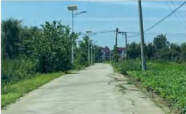
北西路破碎板
