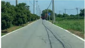
头沈线网裂
