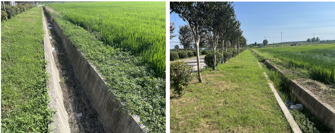
梁江路现状排水
