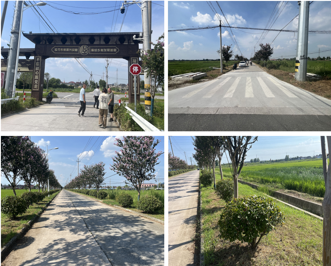
梁江路路基现状
