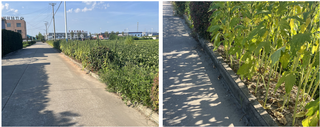
江塘路现状路基防护照片
