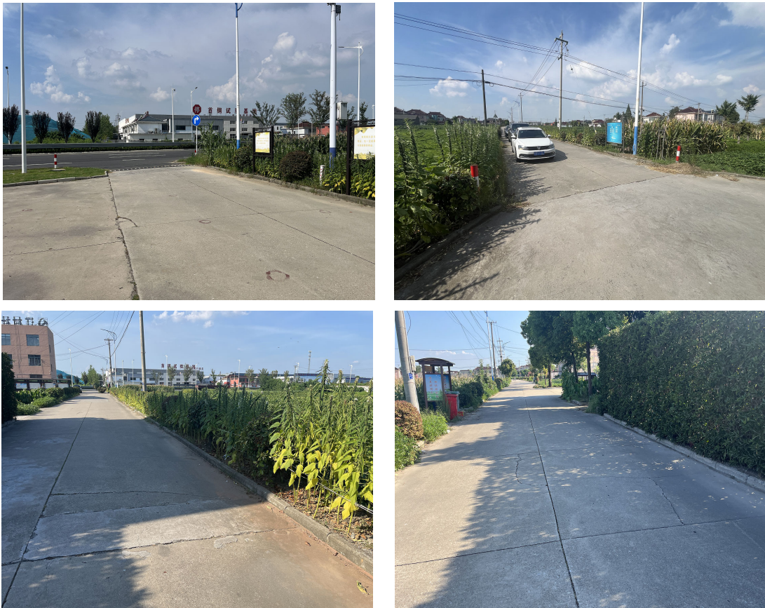
江塘路路基现状
