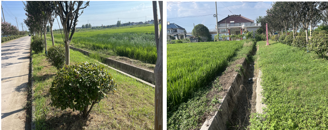
梁江路现状路基防护照片
