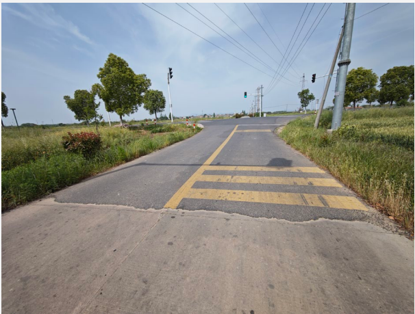
交叉口东侧现状照片
