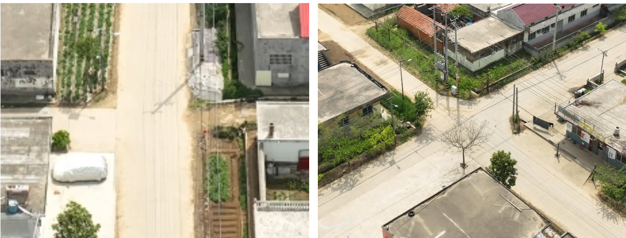
图 4-5 道路路面状况
