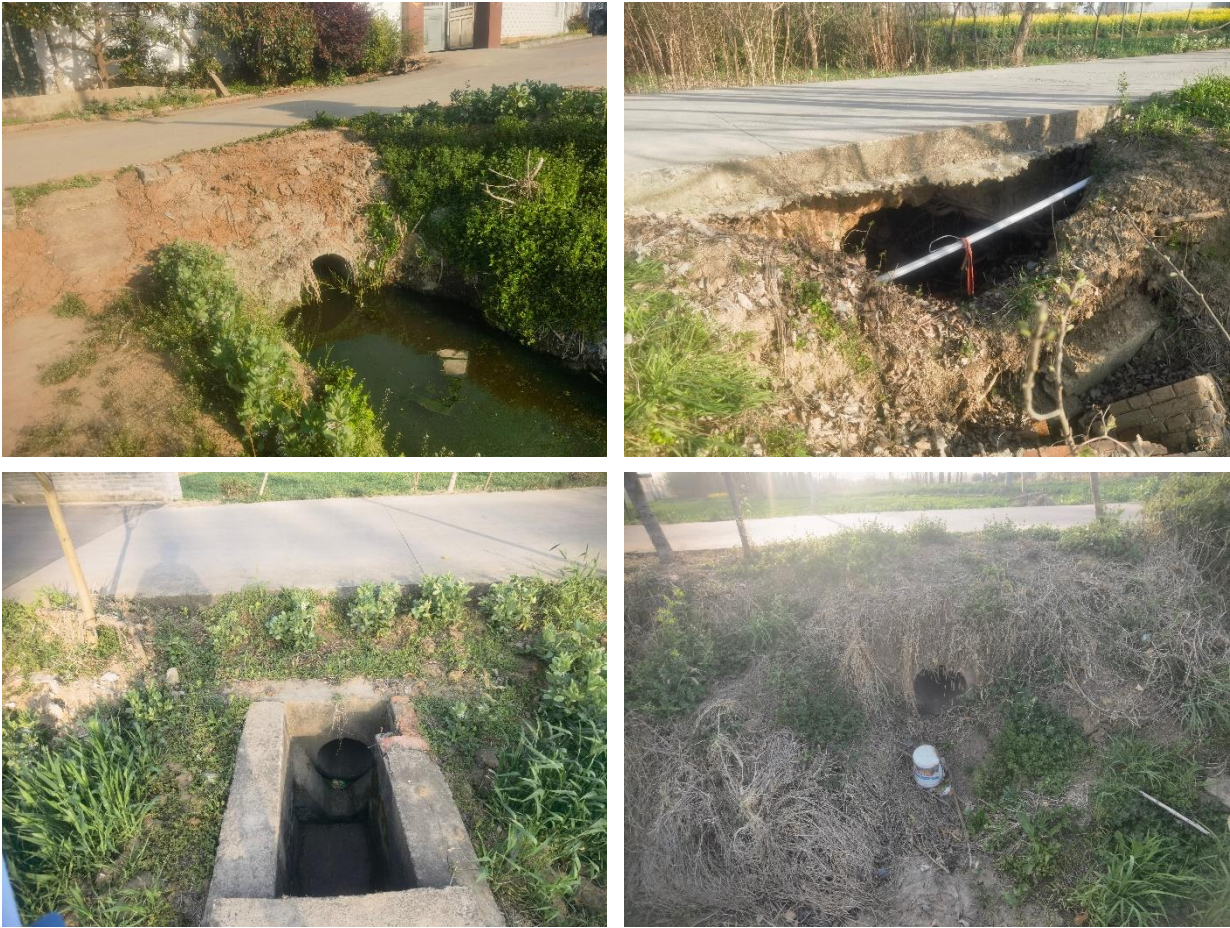
图 12 道路沿线管涵
