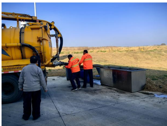
图 a 槽罐车卸料状态
