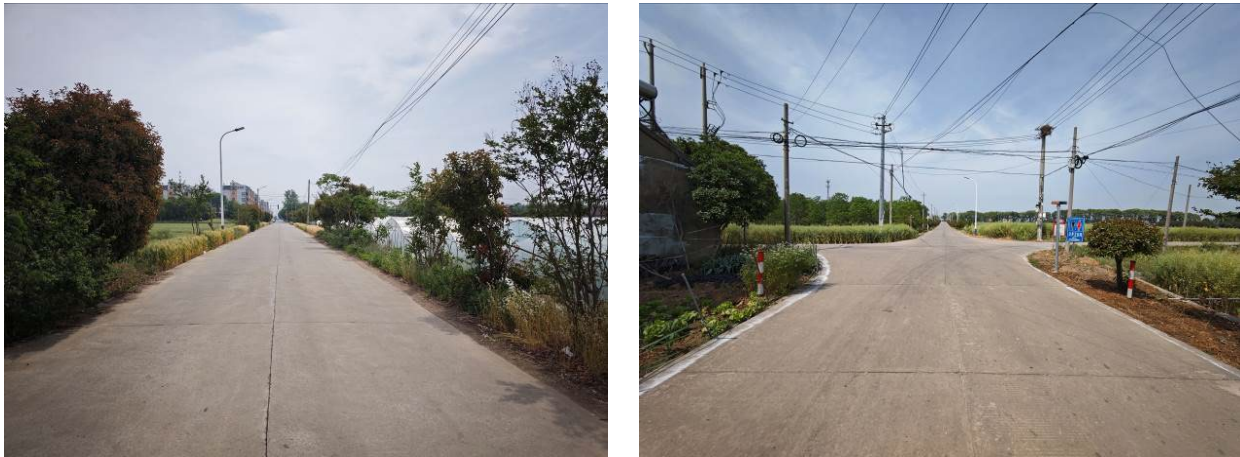
现状横断面照片
