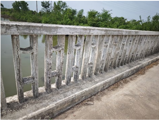
护栏露筋照片
