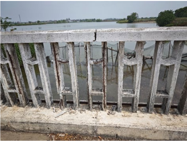
护栏露筋照片
