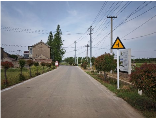
交安设施现状照片
