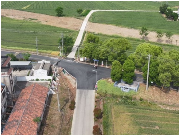
邓下线交叉口现状照片
