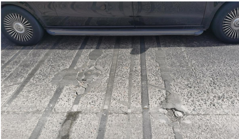
图 2-6 现场路面状况图
