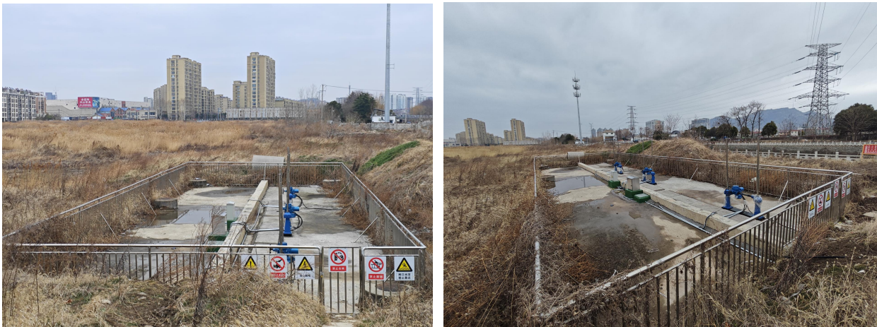
新海路排水沟截流闸门
