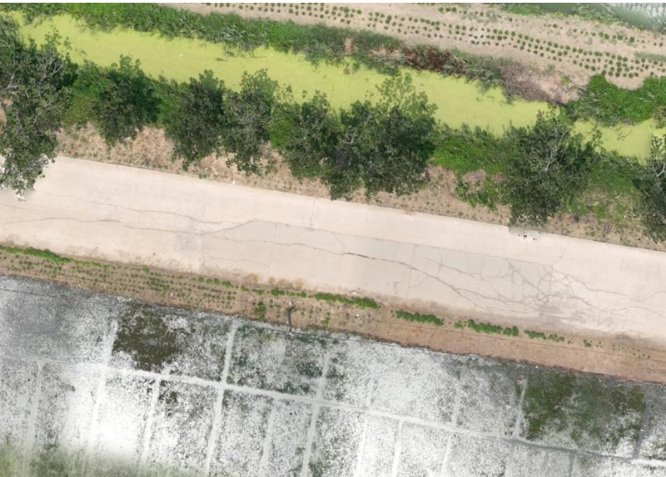
图 4-5-1 现状路面平整度调查图
