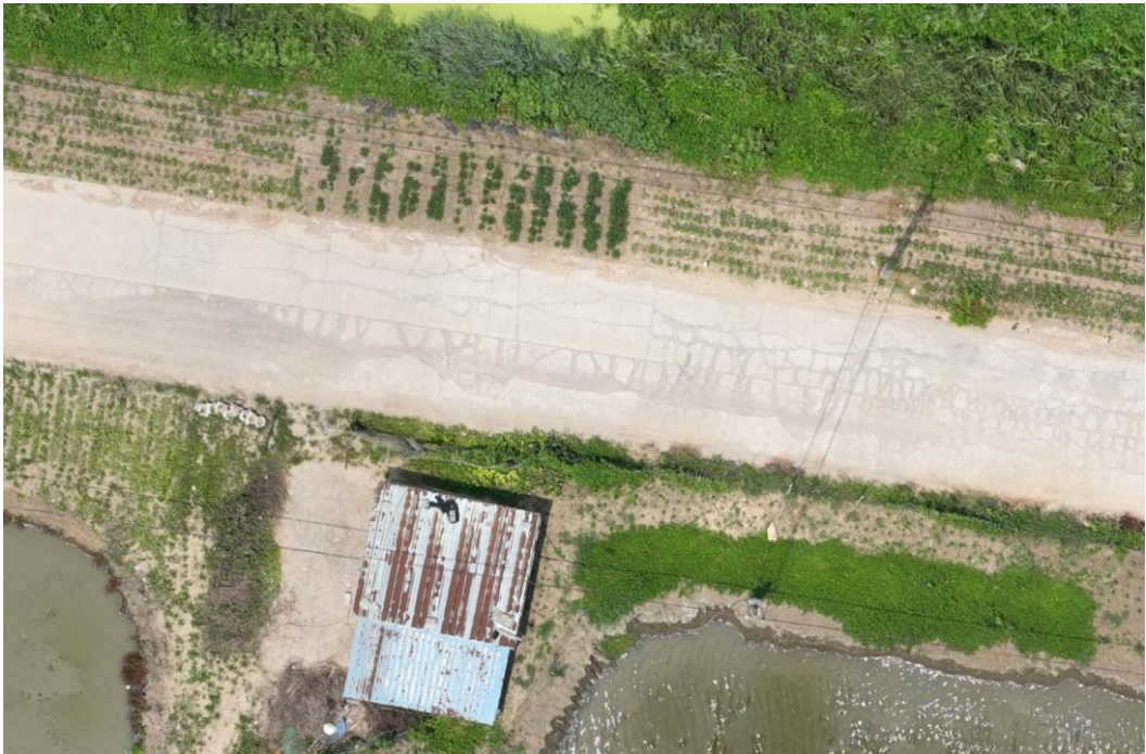
图 4-5-2 现状路面平整度调查图
