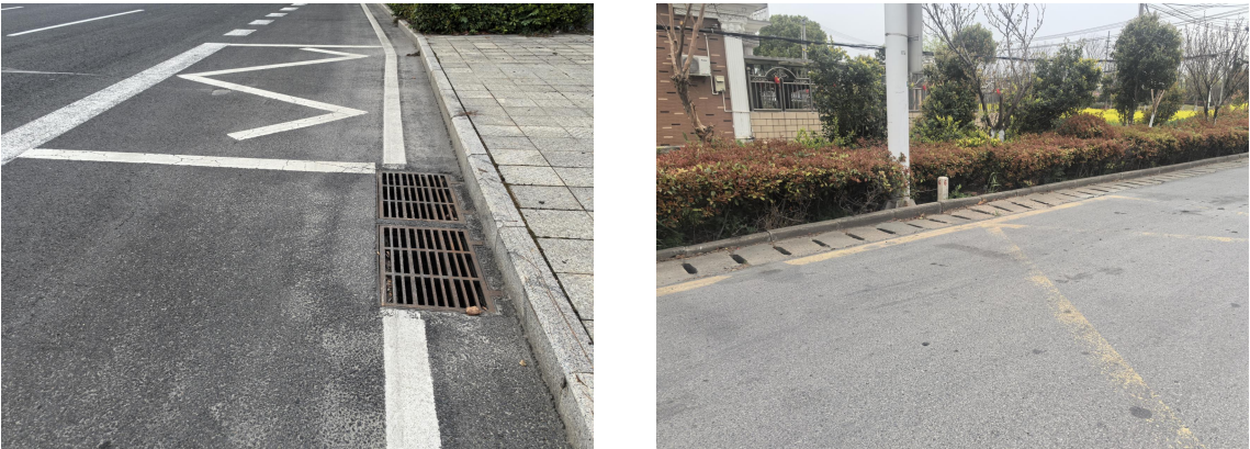
图 2.2-1 道路排水状况调查
