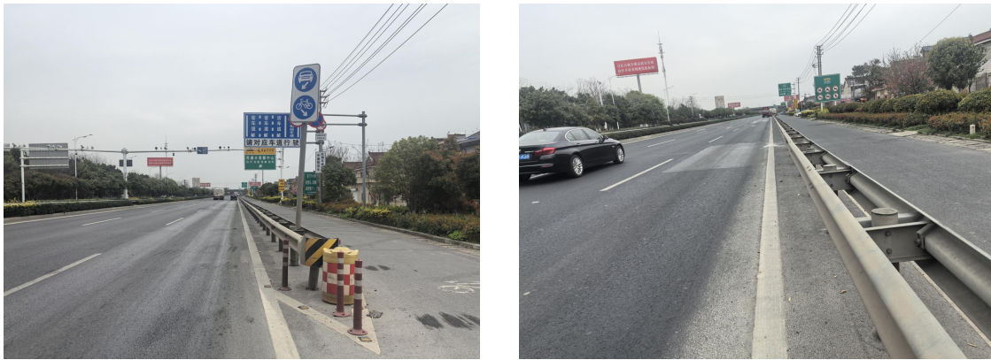
图 2.2-2 沿线安全设施现状
