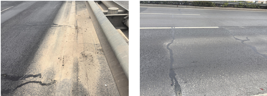
图 2.2-3 横向裂缝
