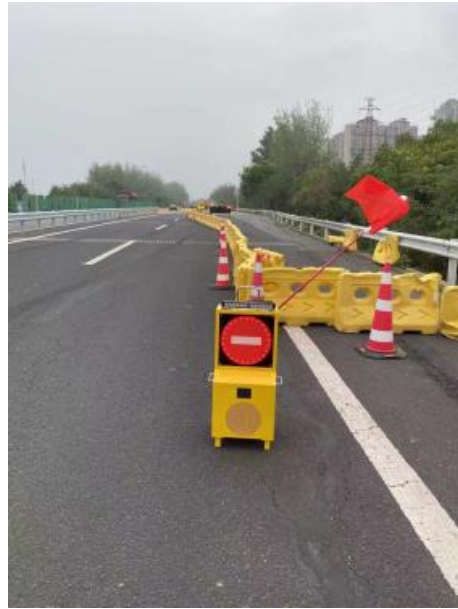
图 6.1-3 双向交替通行的反向弯道路段作业
