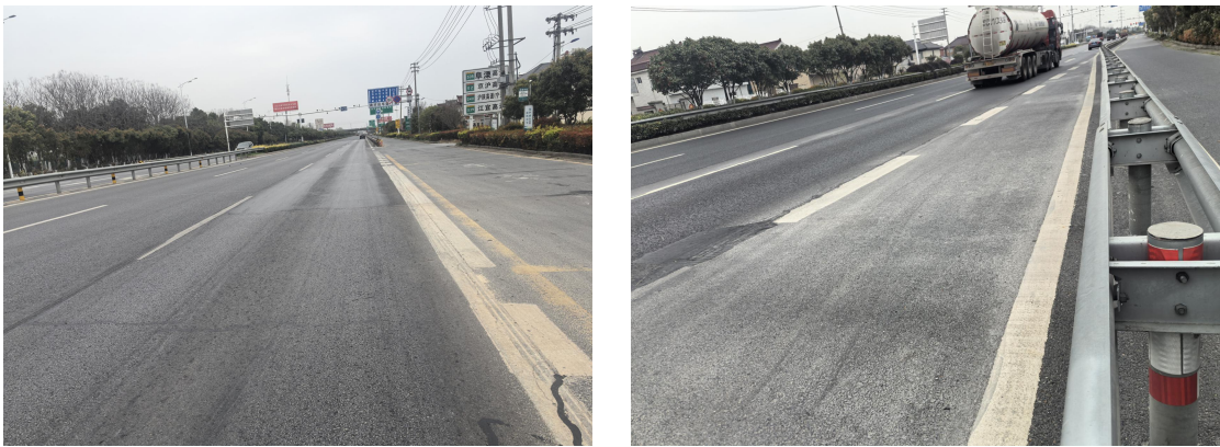
图 2.2-25 纵向裂缝
