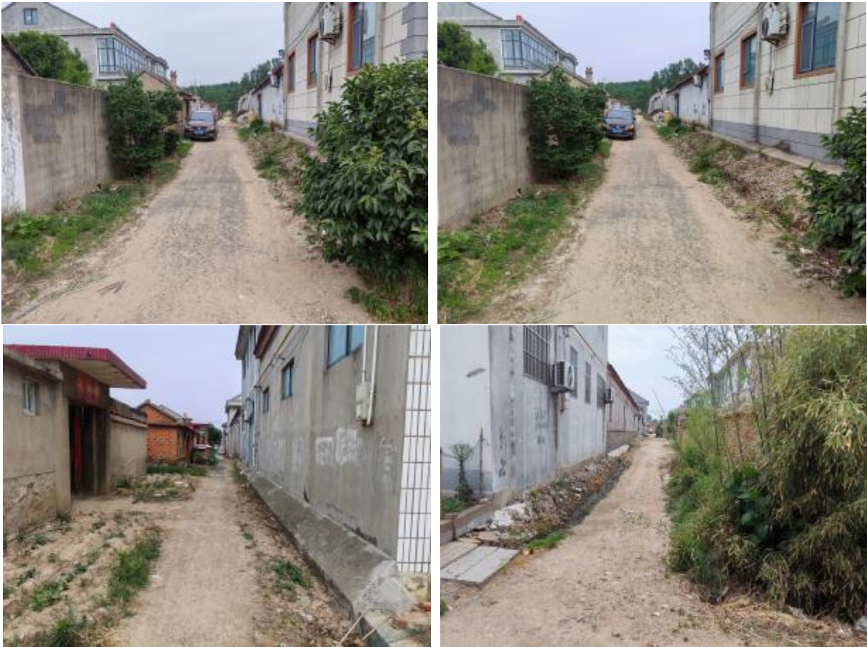
巷道现状照片
