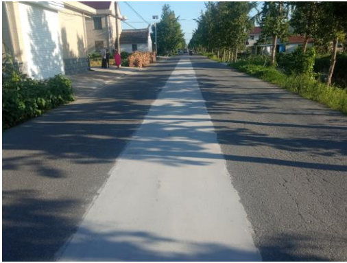
局部水泥砼挖补
