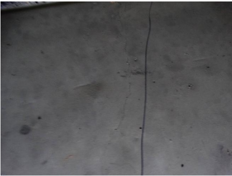
(b) 1-9#右腹板斜向裂缝
