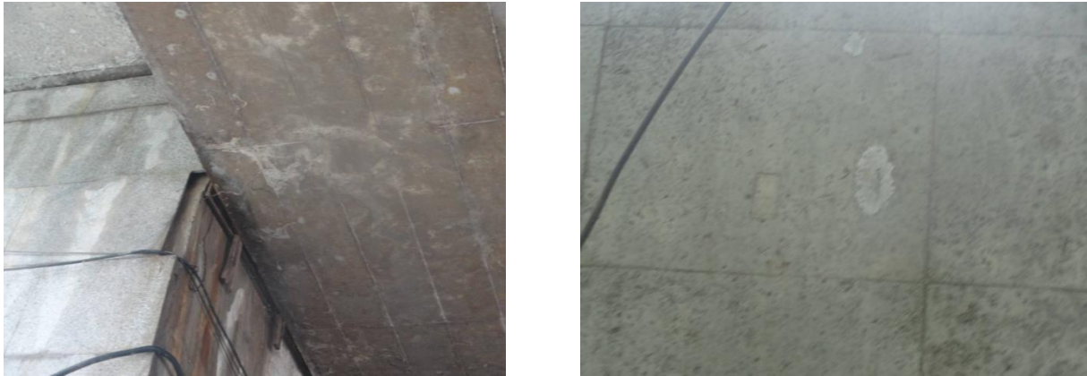
(a) 9#孔箱梁底板横向裂缝，伴析白 (b) 8#孔箱梁左翼板横向裂缝，伴析白
