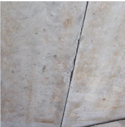
（b）3-4#梁底板破损
