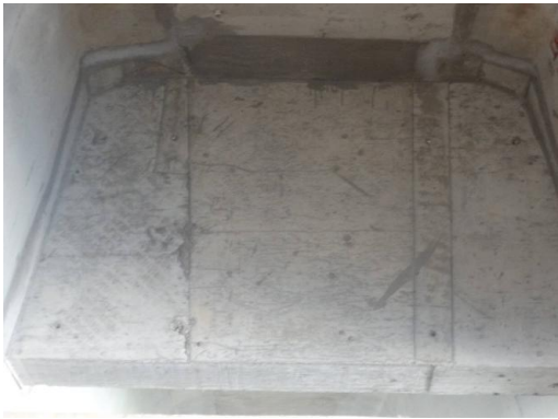
(c) 5-3-1 大桩号面竖向裂缝
