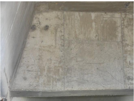
(b) 4-3-3 小桩号面竖向裂缝
