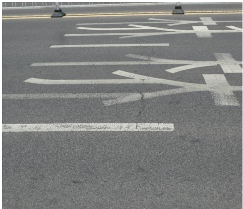
（a）桥面裂缝
