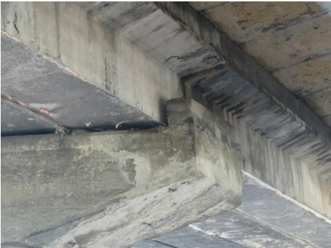
(d) 7-15#梁底板露筋锈蚀，锈胀
