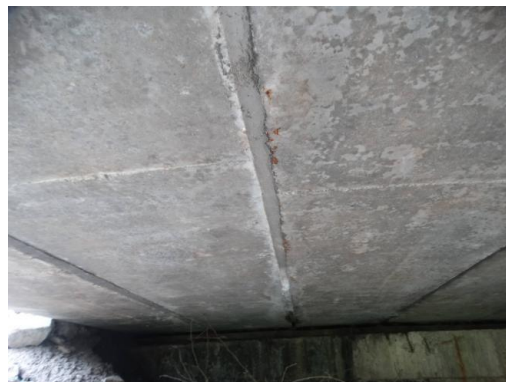
(a) 左幅 L1-4#空心板板底横向裂缝
