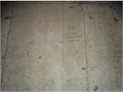
(d) 11-7-3 小桩号面竖向裂缝
