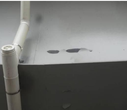
(a) 钢箱梁腹板涂层剥落
