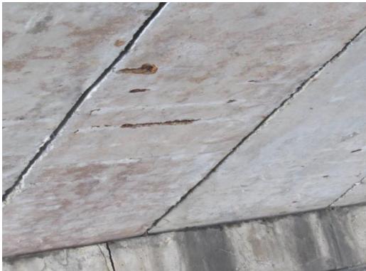
(b) 1-16#梁底板锈胀，露筋锈蚀
