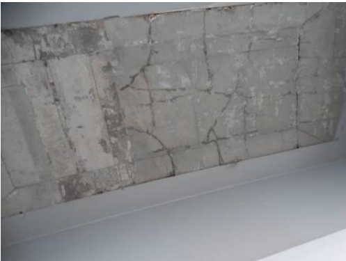
(b) 桥面板底板网裂
