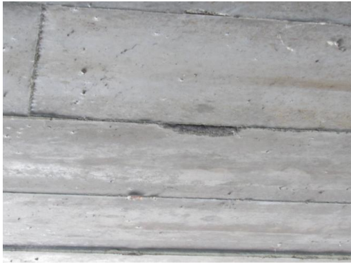
（b）1-15#梁底板破损
