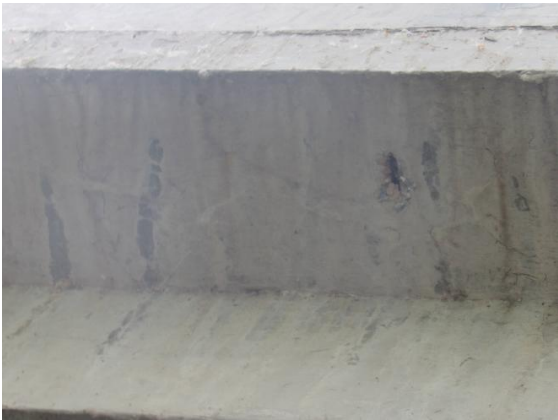
（a）1-43#梁右翼板剥落
