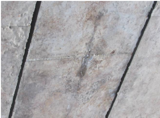
(a) 1-6#梁底板纵向裂缝，析白
