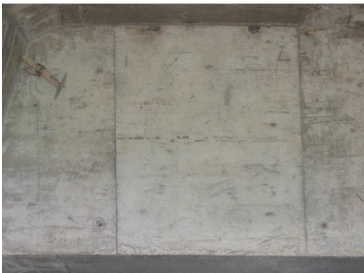
(a) 2-7-1 大桩号面竖向裂缝
