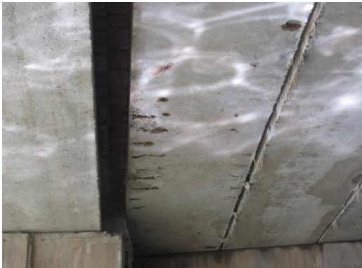
(d) 1-30#梁底板锈胀，露筋锈蚀
