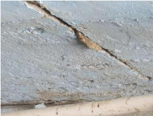
(b) 1-7#梁底板锈胀，露筋锈蚀
