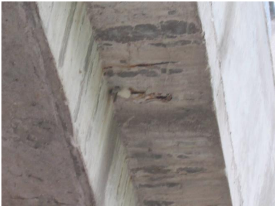
（b）3-43#梁右翼板剥落，露筋（非主筋）
