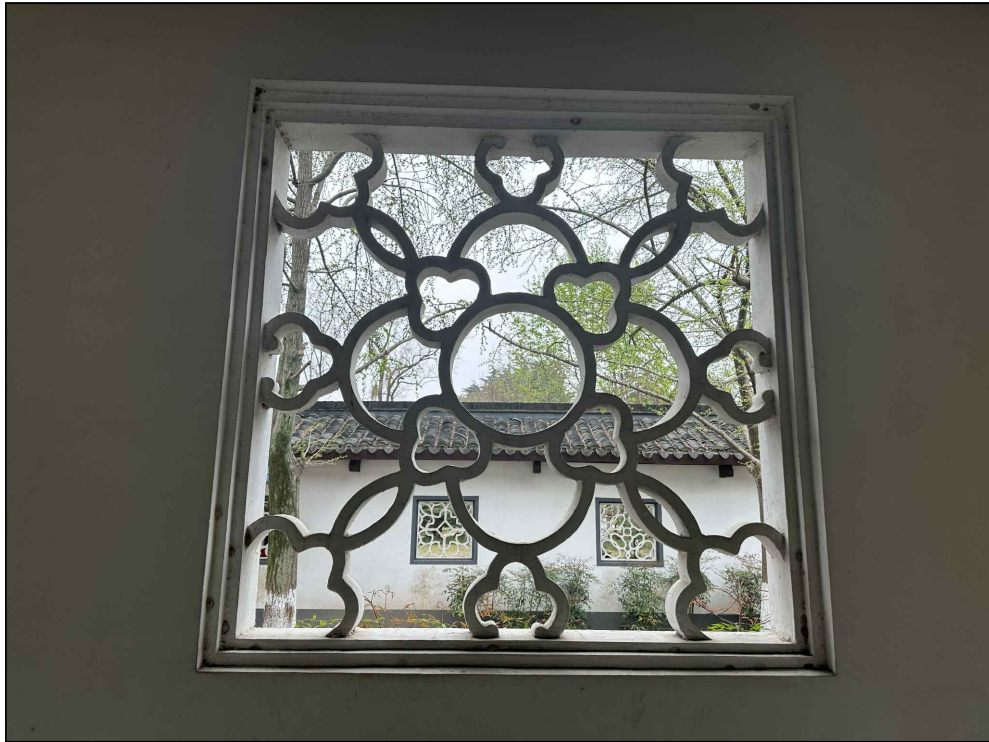
混凝土景窗大样图 1：20 1200*1200，窗框50+50
