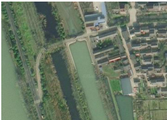
图 1 六周公路与 X251 交叉口现状
