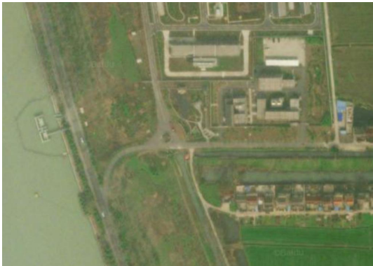
图 9 一支渠路与 X251 交叉口现状
