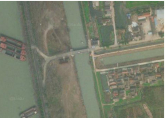
图 12 东甘路与 X251 口交叉口现状
