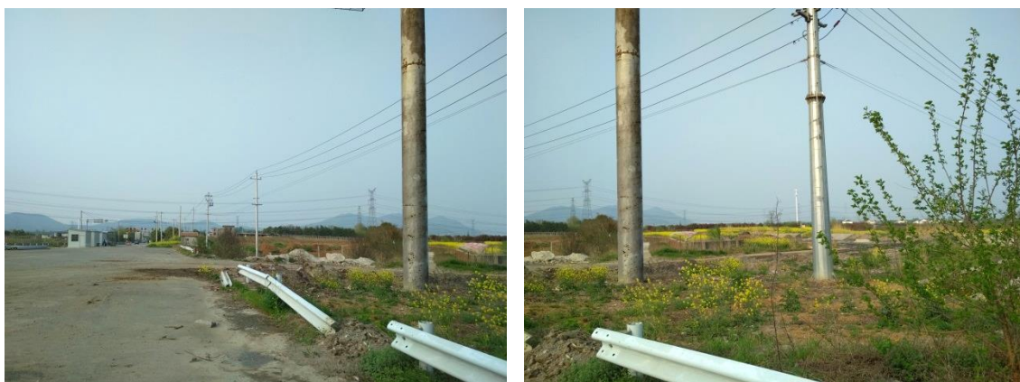
第一水厂选址一 现场照片
