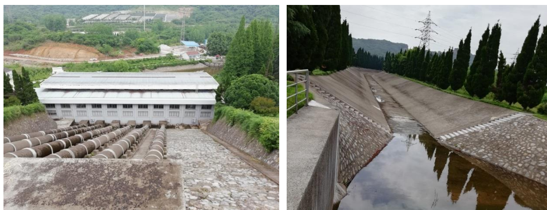
长江提水二站及输水渠道
