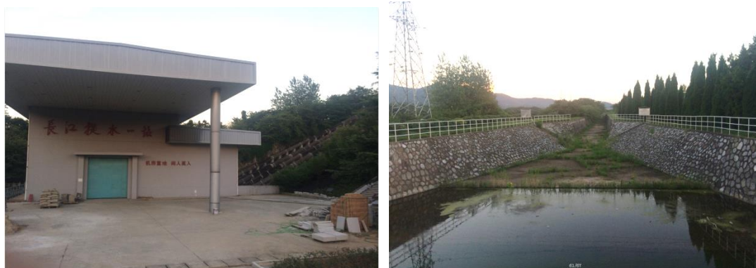
长江提水一站及输水渠道
