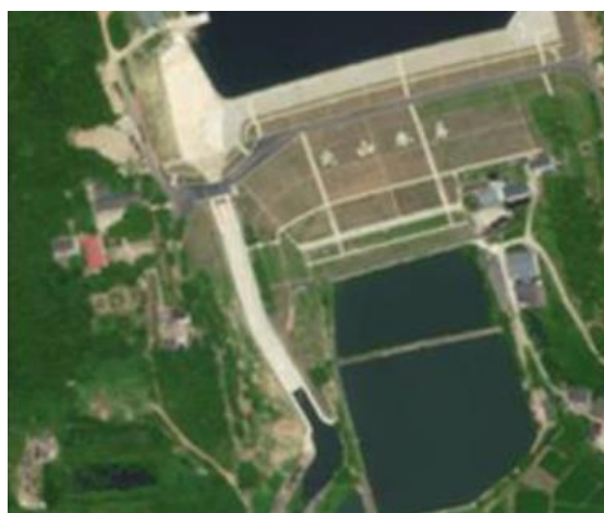
北山水库取水泵站选址二 卫星照片
