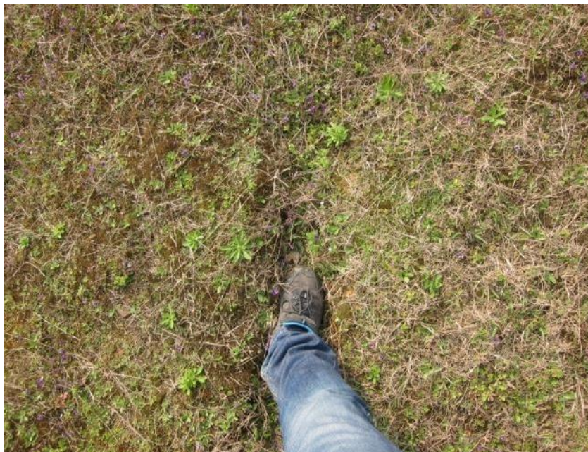
图 4.3-1 背水坡窖湿，坝体渗水，存在雨淋沟
