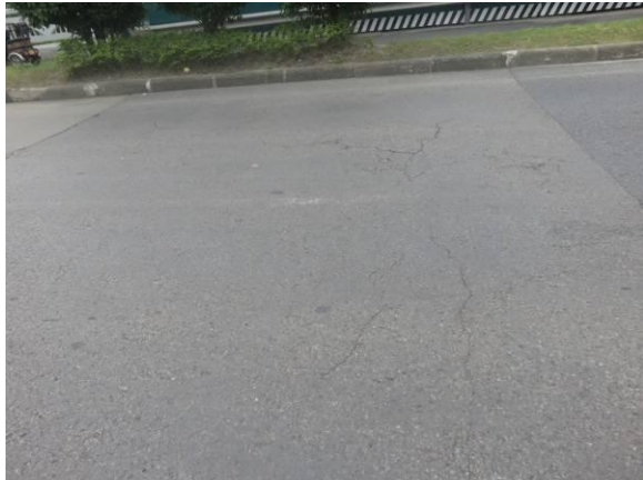
图 4-3 0#台桥路连接桥头跳车
