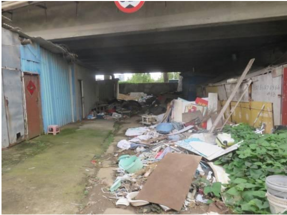
3#孔桥下空间桥下违建
