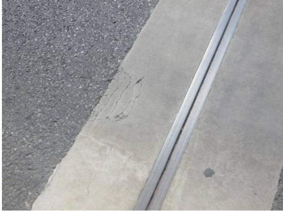
6#伸缩装置右侧机动车道锚固砼破损, 碎裂
