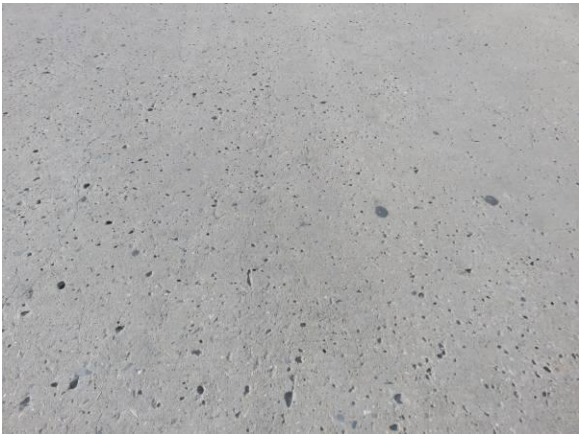
3#孔桥面铺装左侧机动车道纵向裂缝
