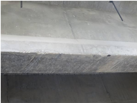
3-1#梁底板破损
