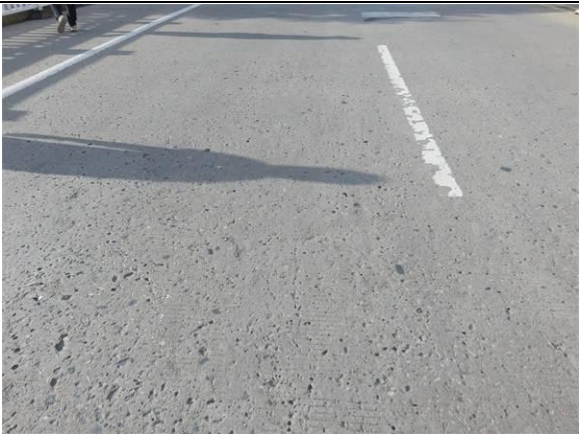
2#孔桥面铺装机动车道纵向裂缝，断续
