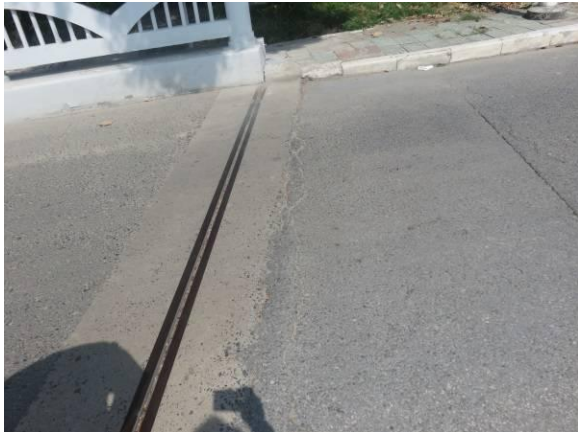
图 4-3 0#台桥路连接桥头跳车
