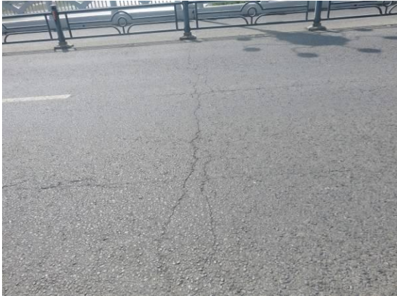
3#伸缩装置左侧非机动车道锚固砼纵桥向开裂
