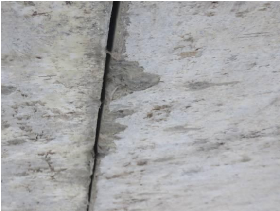
3-16#梁底板破损
