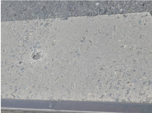
3#伸缩装置左侧非机动车道锚固砼纵桥向开裂
