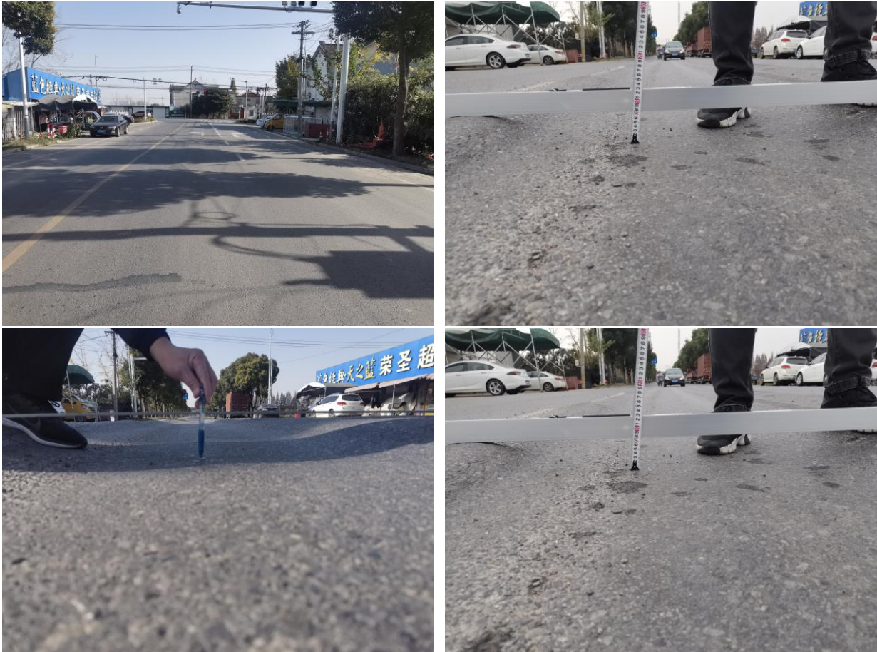
图 2-9 X202（与吴桥路交叉口西侧渠化段）
