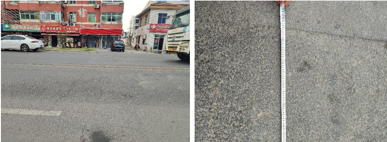
图 2-11 过路管道第一处 宽 0.5m
