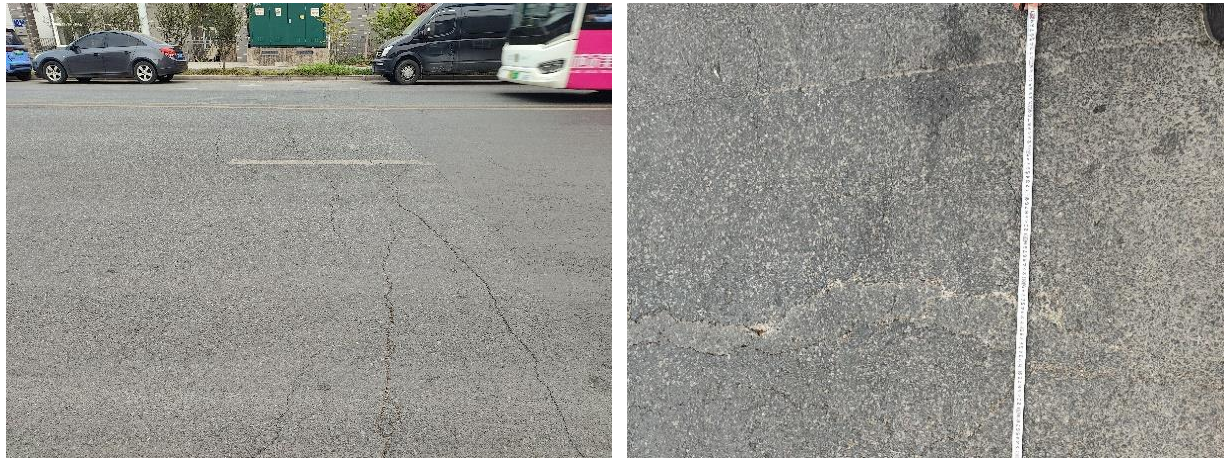
图 2-12 过路管道二处 宽 1.5m
