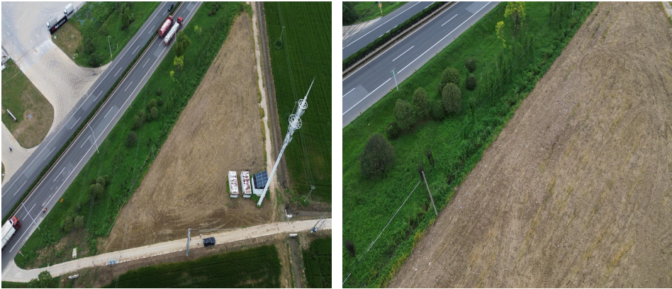
325 省道北侧场地现状
