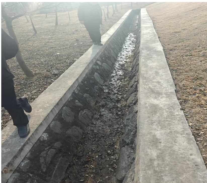
图 4-2 导渗沟积水
