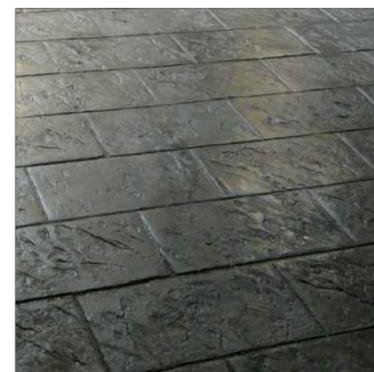
压模混凝土样式二 (颜色详见平面图)
