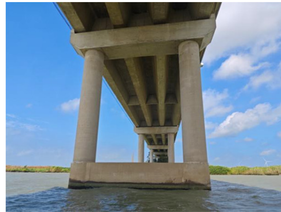
41#墩大桩号侧状况照
