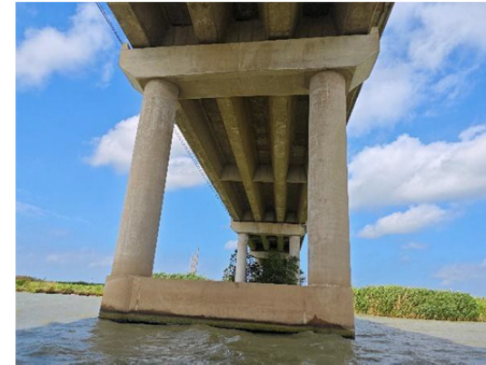
40#墩大桩号侧状况照
