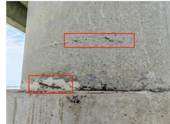
69-1#墩锈胀露筋
