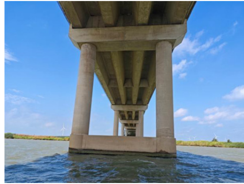
42#墩大桩号侧状况照
