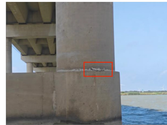
53-1#墩锈胀露筋
