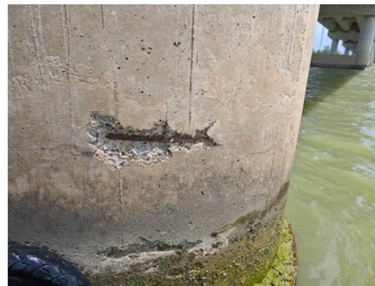
66-3#墩锈胀露筋
