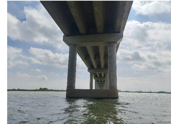
40#墩小桩号侧状况照
