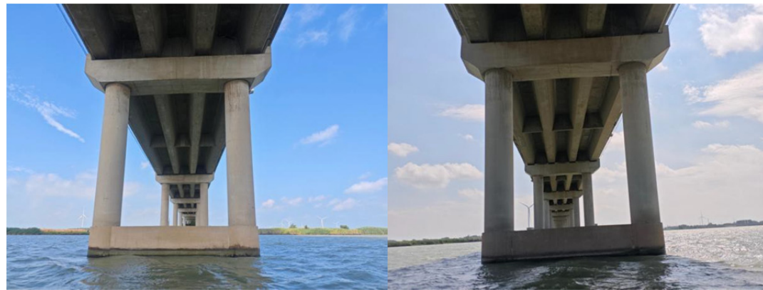
43#墩大桩号侧状况照
