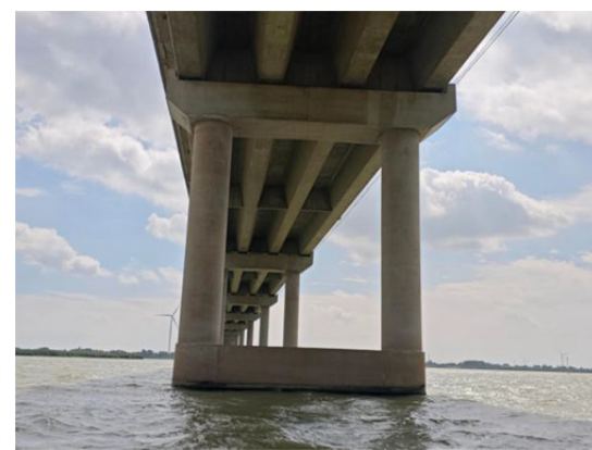
41#墩小桩号侧状况照
