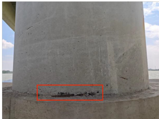
58-2#墩锈胀露筋
