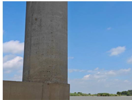
58-1#墩锈胀露筋
