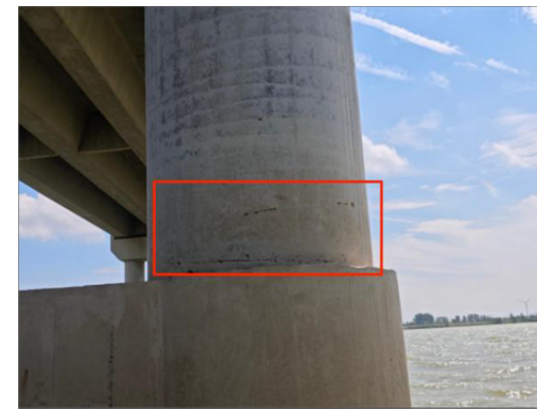
57-3#墩锈胀露筋
