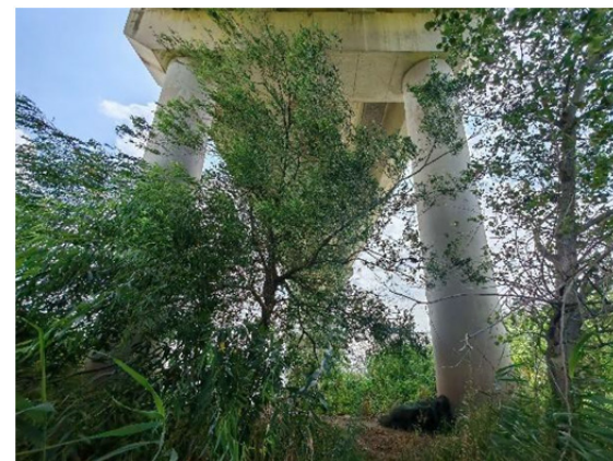
图 39#墩小桩号侧状况照
