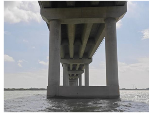
42#墩小桩号侧状况照
