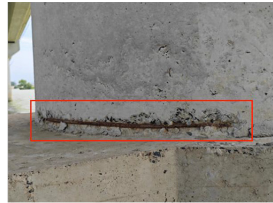
67-2#墩锈胀露筋
