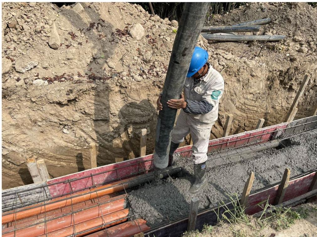
图 3.3-1 混凝土浇筑
