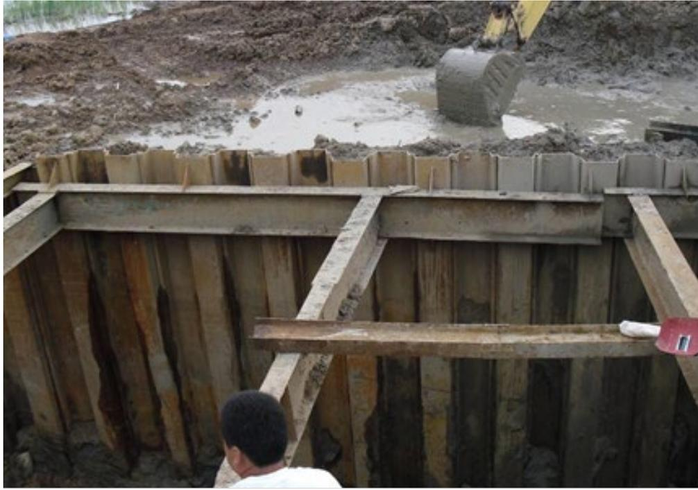
图 3.4-2 拉森桩支护实例图
