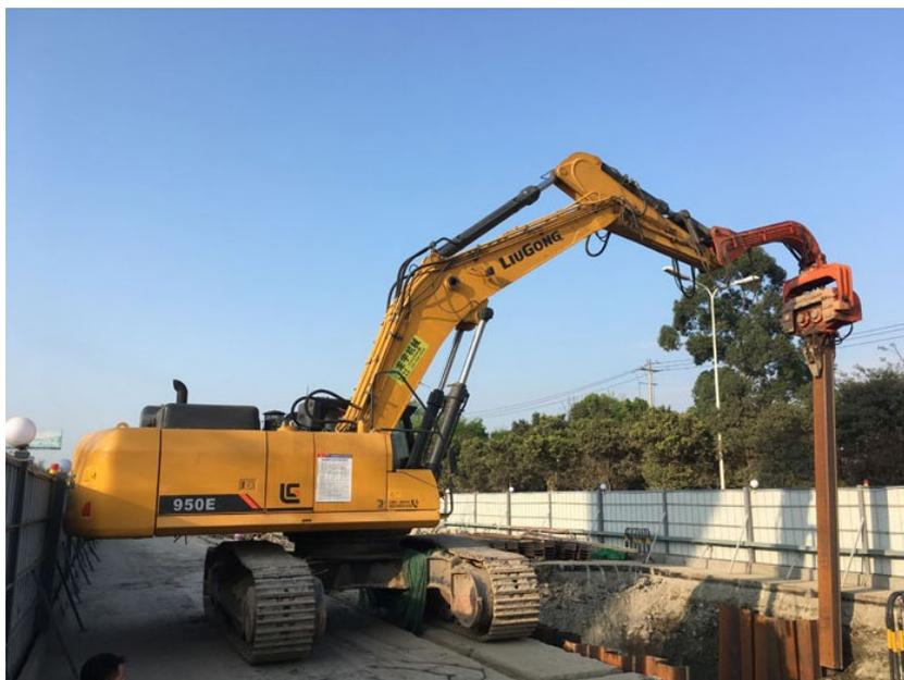
图 3.2-2 钢板桩围护在工程实际中处理图
