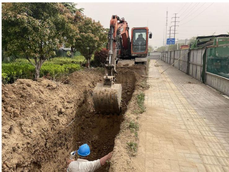
图 3.2-1 挖掘机开挖
