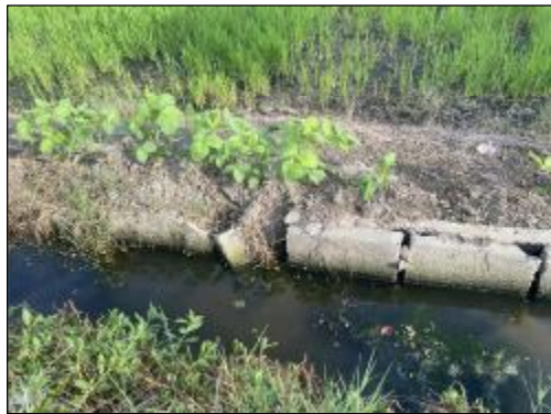
柳南九组（原南濠庄三组）渠道 实施情况：渠道维修，U60渠，维修长度100.0m
