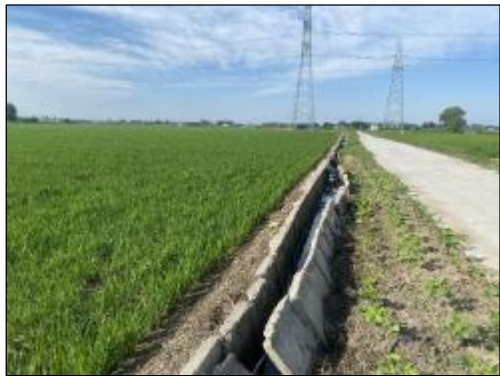
少游七组渠道 实施情况：渠道维修，U70渠，维修长度150.0m
