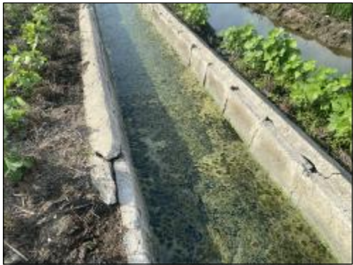
少游八组渠道 实施情况：渠道维修，U80渠，维修长度150.0m
