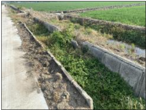
少游二组渠道 实施情况：渠道维修，U90渠，维修长度100.0m
