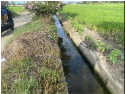
柳南九组（原南濠庄三组）渠道 实施情况：渠道维修，U60渠，维修长度100.0m
