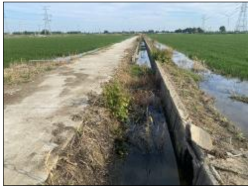
少游二组渠道 实施情况：渠道维修，U90渠，维修长度100.0m
