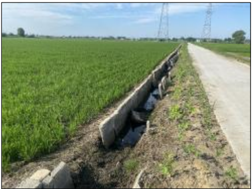
少游七组渠道 实施情况：渠道维修，U70渠，维修长度150.0m
