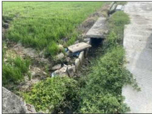
少游八组渠道 实施情况：渠道维修，U80渠，维修长度150.0m
