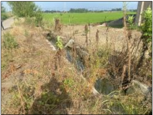
少游东村三组渠道 实施情况：渠道维修，U80渠，维修长度200.0m
