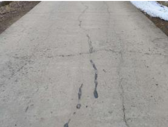
图 1-4 破碎板
