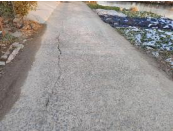
图 1-4 破碎板
