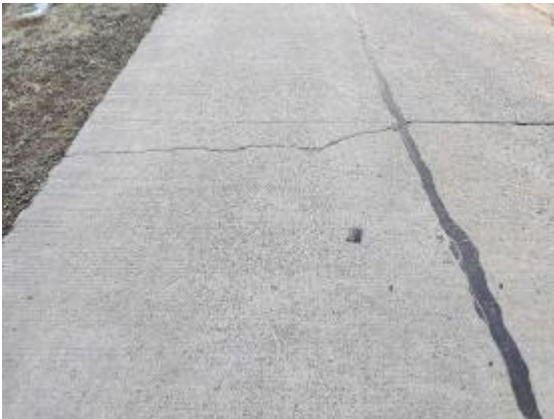
图 1-5 板角断裂
