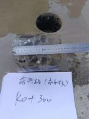
1#砼板块，混凝土面层厚度 16cm，基层松散未取出。
