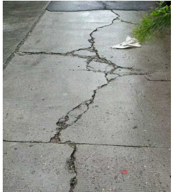
现状路面缝隙修补
