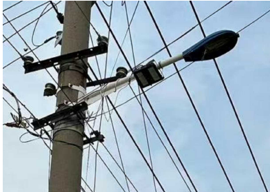
北侧现状路灯更换及电线杆出新
