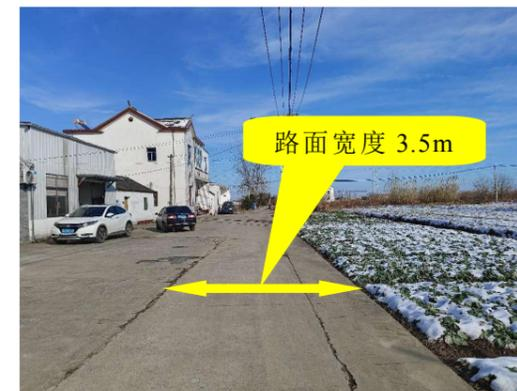
实施方案：K1+275-K1+365 段：老路路面宽 3.5m，为住户门前段，综合现场调查、检测情况结合业主意见对本段“挖除新建”。改造后断面形式为 5m 路基 4m 沥青混凝土路面。
