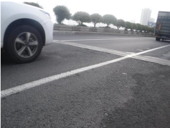
图 2-4 南幅 7#台后跳车
