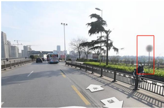
图 4-3 西侧桥面变窄警示牌安装位置
