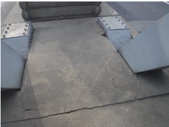
图 2-6 南幅 4#孔左侧护栏构件缺失
