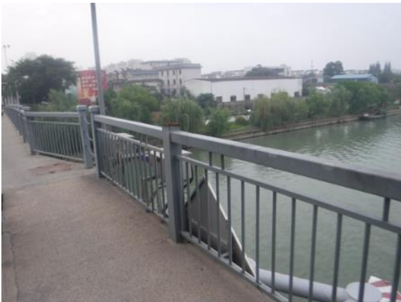
图 2-6 南幅 4#孔左侧护栏构件缺失
