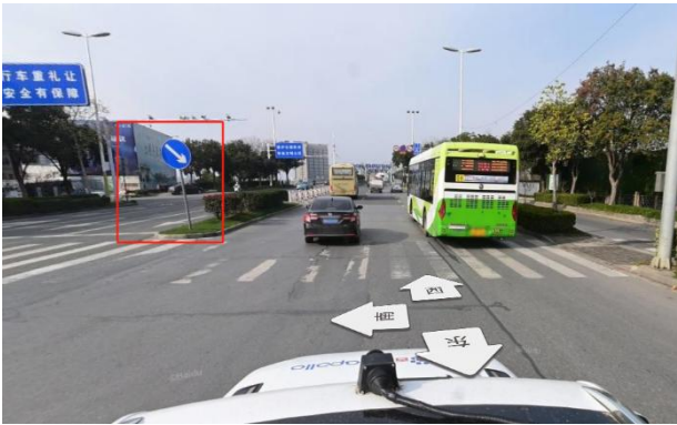
图 4-2 东侧桥面变窄警示牌安装位置
