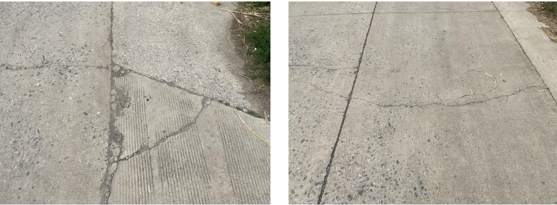
图 1-5 板角断裂
