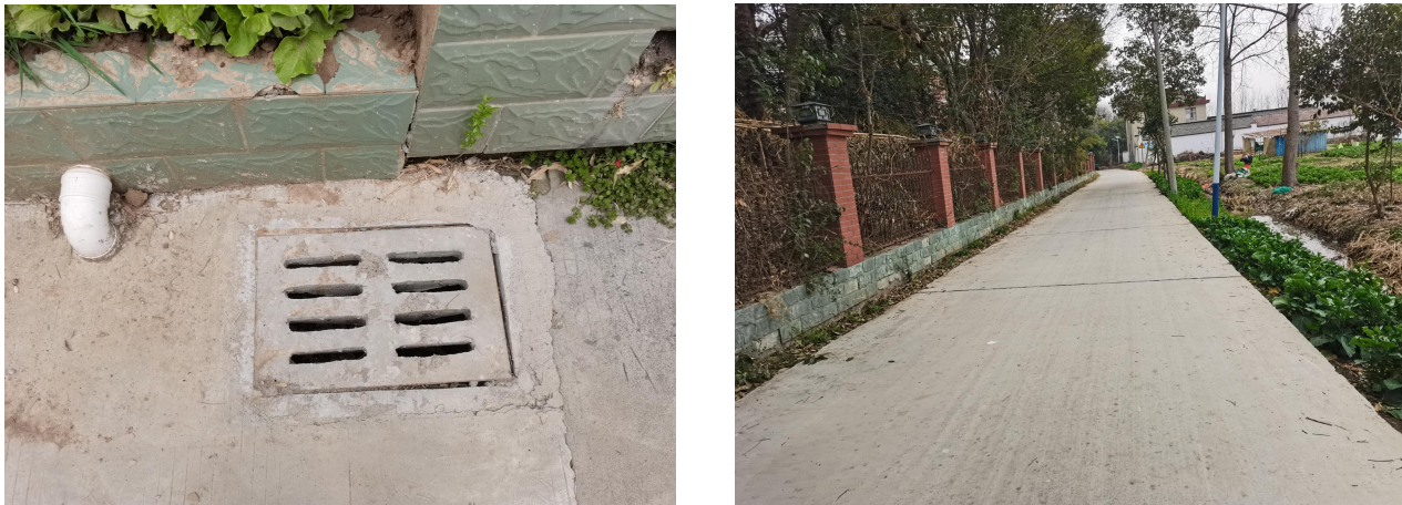
图 2-6 路基、路面排水现状图
