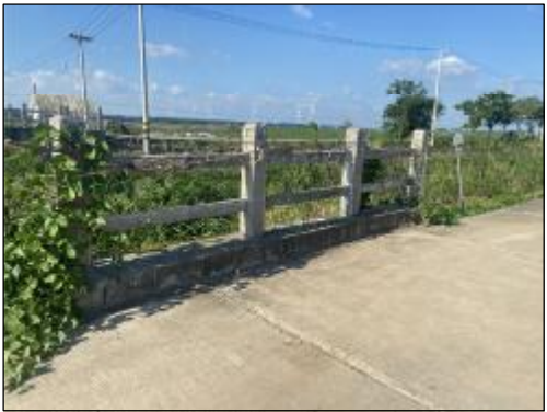
合心村汲水5组3号桥 实施情况：桥梁栏杆拆除新建，长度12.0m
