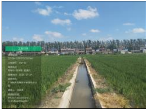
董潭村渠道-02 实施情况：渠道维修，U70渠，长度20m
