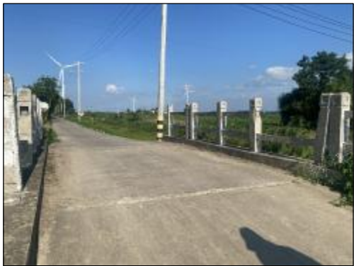
合心村汲水5组3号桥北桥 实施情况：桥梁栏杆拆除新建，长度18.0m
