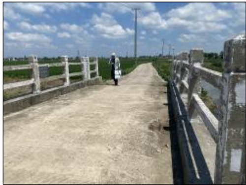
薛北村薛北5组桥 实施情况：桥梁栏杆拆除新建，长度23.0m
