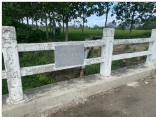
果林社区沿河二号路桥 实施情况：混凝土栏杆维修，长度2.0m，全桥护栏刷白
