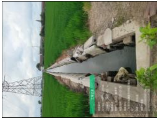
董潭村渠道-10 实施情况：渠道维修，T90渠，长度50m
