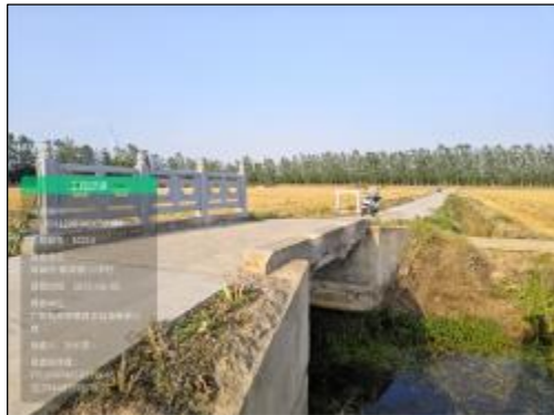
川东村桥梁 实施情况：桥梁单侧栏杆新建，需凿除现状缘石并新建，长度6.0m
