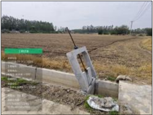
川东村水闸 实施情况: T90渠节制闸拆除新建
