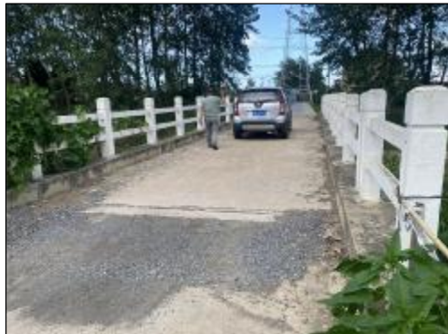
果林社区先进组1桥 实施情况：桥头接线凿除新建
