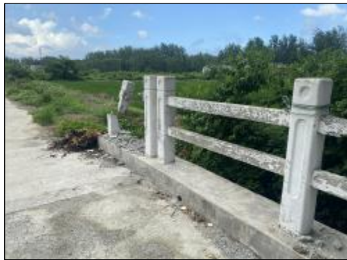
果林社区果林东园生产桥 实施情况：混凝土栏杆维修，长度10.0m，全桥护栏刷白
