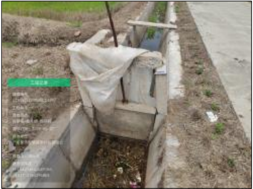
周巷村水闸-25 实施情况: T90渠节制闸拆除新建
