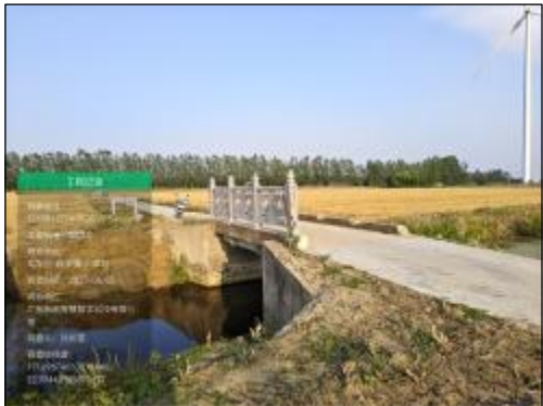
川东村桥梁 实施情况：桥梁单侧栏杆新建，需凿除现状缘石并新建，长度6.0m
