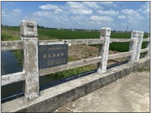
薛北村薛北5组桥 实施情况：桥梁栏杆拆除新建，长度23.0m
