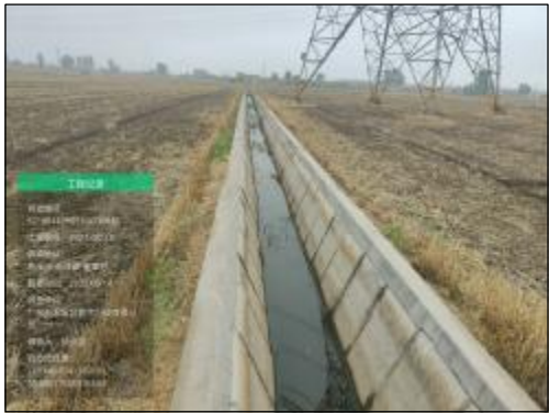
董潭村渠道-10 实施情况：渠道维修，T90渠，长度50m
