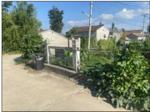
合心村汲水5组3号桥 实施情况：桥梁栏杆拆除新建，长度12.0m
