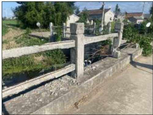
合心村汲水跃进河桥 实施情况：桥梁栏杆拆除新建，长度38.0m
