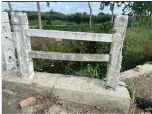
果林社区中心河生产桥 实施情况：混凝土护栏维修，长度1m，全桥护栏刷白
