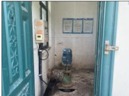
薛北村刑西泵站 实施情况：抽水泵整体抬升80cm，泵身加长80cm，出水池加高80cm，内部电箱及其他同步提升改造
