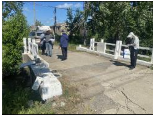
双马村双兔桥 实施情况：栏杆拆除重建，长度14.0m, 桥头接线凿除新建
