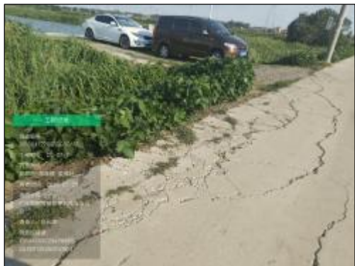
董潭村路面007 实施情况：道路修补，路面宽度3.0m，修补长度30m
