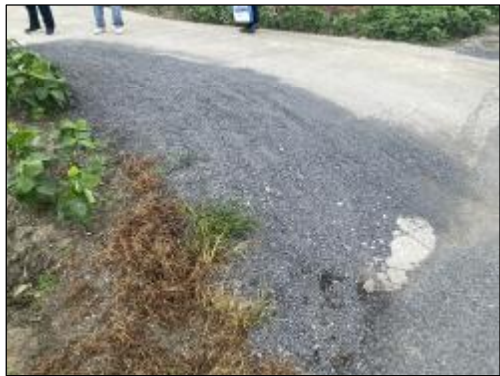
小葛村路面 实施情况：路面维修26m²，灌缝20.0m
