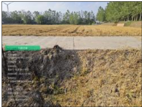
川东村涵洞 实施情况：拆除新建，直径60cm节制涵洞，长度5.0m
