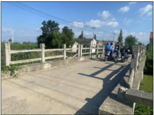
合心村汲水跃进河桥 实施情况：桥梁栏杆拆除新建，长度38.0m
