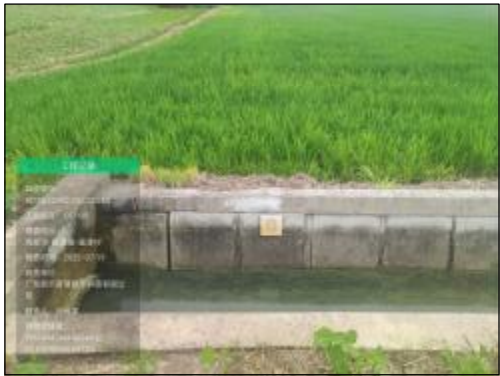
董潭村渠道-05 实施情况：渠道维修，T90渠，长度20m
