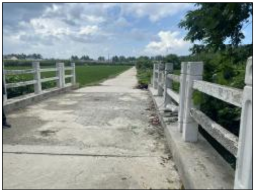
果林社区果林东园生产桥 实施情况：混凝土栏杆维修，长度10.0m，全桥护栏刷白
