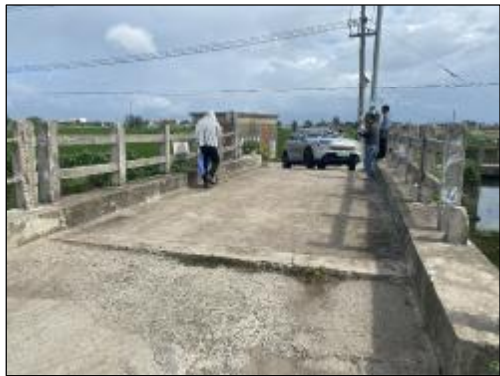
西河村临南9组3号河桥 实施情况：桥梁护栏拆除重建，长度24.0m
