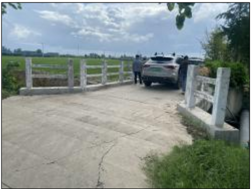
果林社区中心河生产桥 实施情况：混凝土护栏维修，长度1m，全桥护栏刷白
