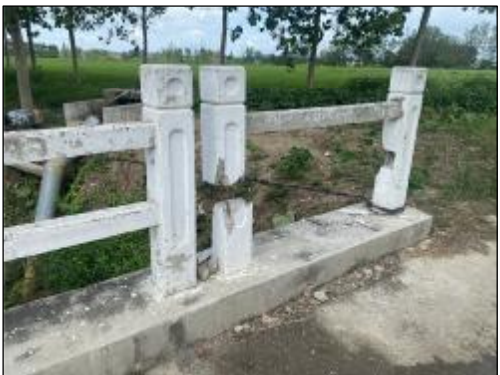
果林社区沿河二号路桥 实施情况：混凝土栏杆维修，长度2.0m，全桥护栏刷白
