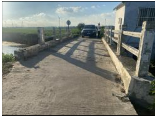
朱堆村周连胜利河桥 实施情况：桥梁栏杆拆除新建，长度21.0m
