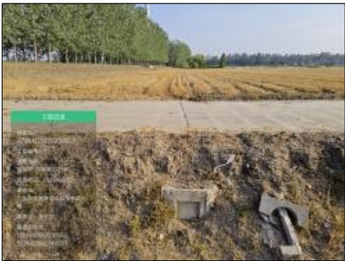
川东村涵洞 实施情况：拆除新建，直径60cm节制涵洞，长度5.0m
