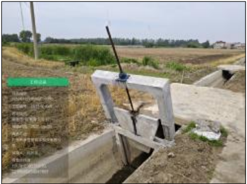
川东村水闸 实施情况: T90渠节制闸拆除新建
