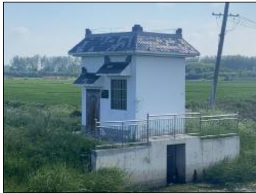
韩夏村仲庄7组东泵站 实施情况：更换屋顶瓦片
