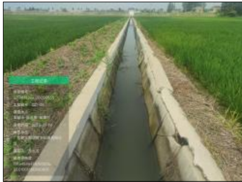
董潭村渠道-05 实施情况：渠道维修，T90渠，长度20m
