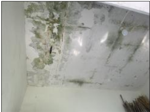
董潭村12组2号泵站 实施情况：顶漏水维修，尺寸3.6*4.0m
