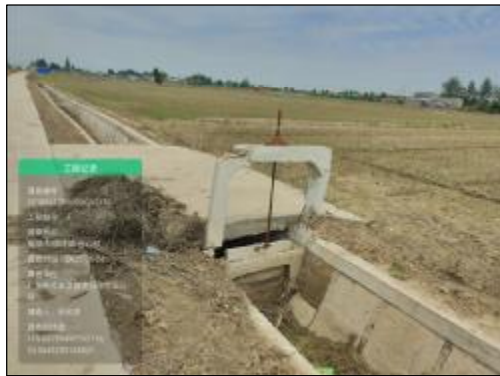
合心村渠道-31 实施情况：渠道维修，T90渠，长度100m
