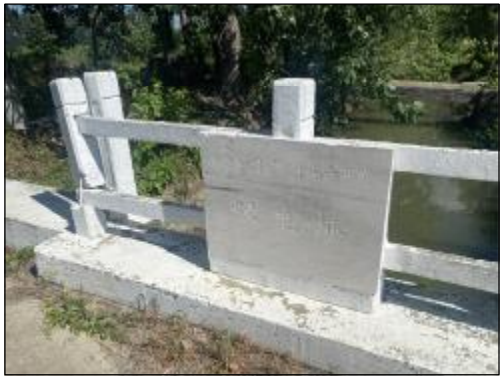
双马村双兔桥 实施情况：栏杆拆除重建，长度14.0m, 桥头接线凿除新建
