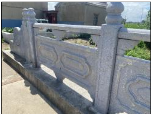
董潭村同心2桥 实施情况：桥梁栏杆拆除新建，长度10.0m
