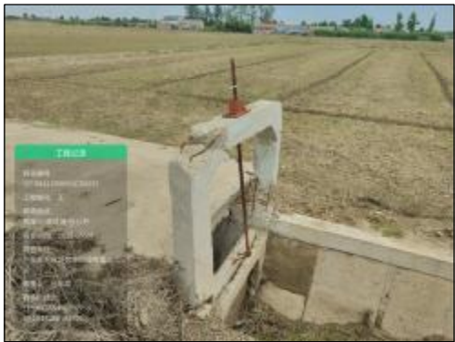
合心村渠道-31 实施情况：渠道维修，T90渠，长度100m
