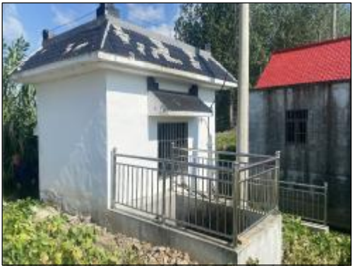
韩夏村仲庄2组泵站 实施情况：更换屋顶瓦片，台阶出新
