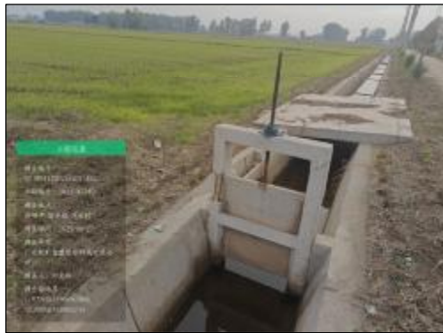
周巷村水闸-29 实施情况：T90渠节制闸拆除新建
