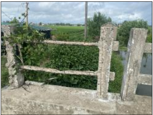
西河村临南9组3号河桥 实施情况：桥梁护栏拆除重建，长度24.0m
