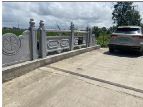
董潭村同心2桥 实施情况：桥梁栏杆拆除新建，长度10.0m
