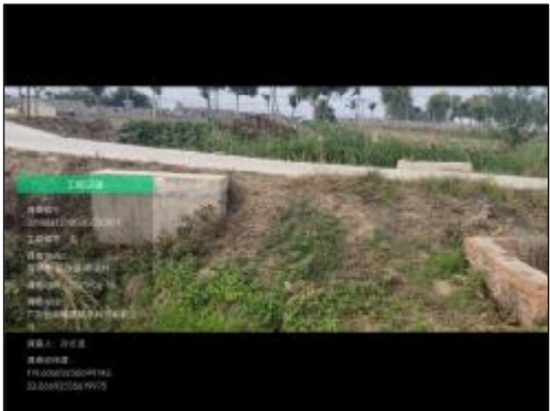
韩夏村涵洞 实施情况：拆除新建，直径60cm节制涵洞，长度4.0m
