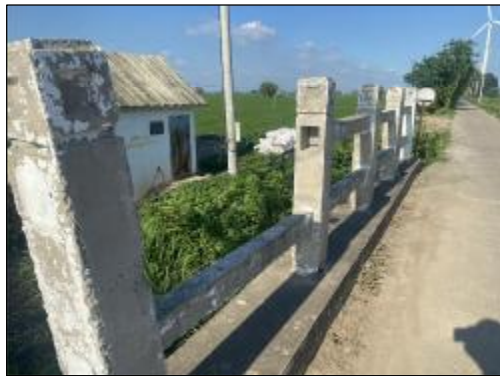
合心村汲水5组3号桥北桥 实施情况：桥梁栏杆拆除新建，长度18.0m
