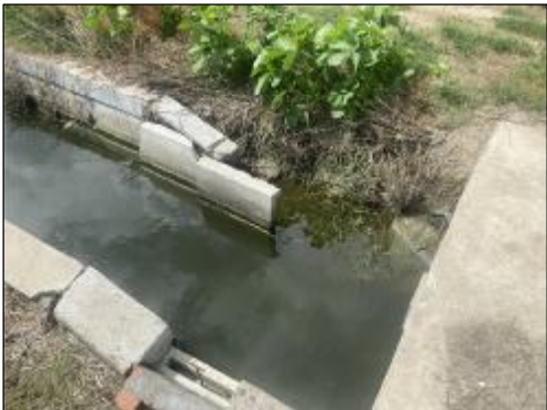
川东11组渠道 实施情况：渠道维修，U70渠，长度20.0m；加高20cm压顶，长度30.0m，渠道压顶维修，长度50.0m，渠道抹缝150.0m
