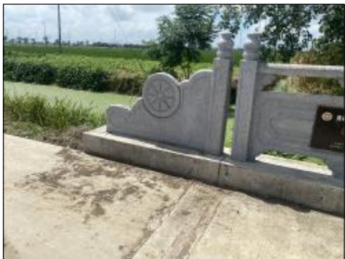
董潭村建通2桥 实施情况：护栏抱鼓石损坏1处，需维修更换
