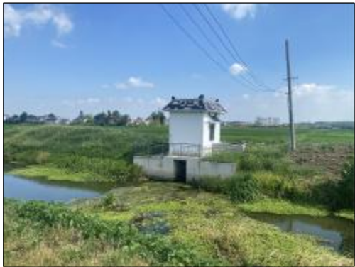
韩夏村仲庄7组东泵站 实施情况：更换屋顶瓦片
