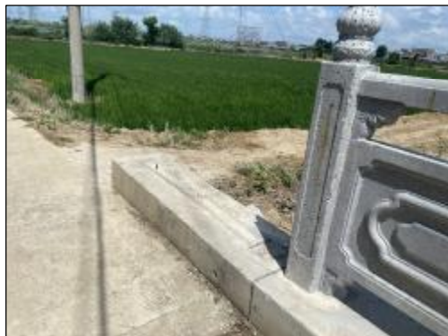
董潭村建通2桥 实施情况：护栏抱鼓石损坏1处，需维修更换
