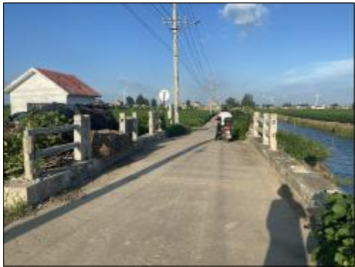
朱堆村徐平中心路2桥 实施情况：桥梁栏杆拆除新建，长度21.0m
