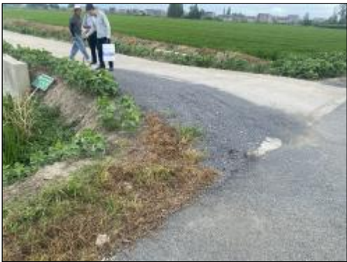
小葛村路面 实施情况：路面维修26m²，灌缝20.0m
