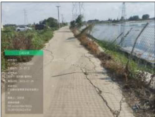
董潭村路面007 实施情况：道路修补，路面宽度3.0m，修补长度30m
