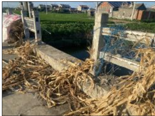
朱堆村徐平4组北桥 实施情况：桥梁栏杆拆除新建，长度21.0m
