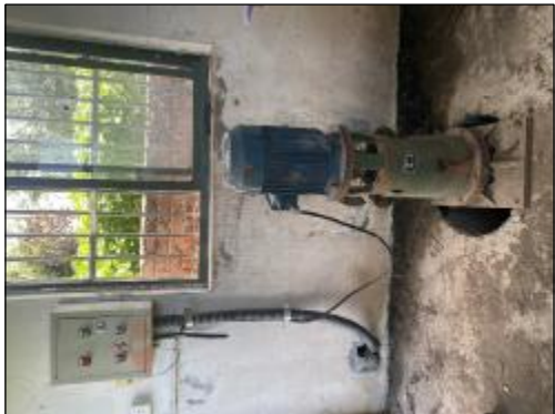
薛北村刑西泵站 实施情况：抽水泵整体抬升80cm，泵身加长80cm，出水池加高80cm，内部电箱及其他同步提升改造
