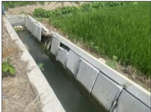
川东11组渠道 实施情况：渠道维修，U70渠，长度20.0m；加高20cm压顶，长度30.0m，渠道压顶维修，长度50.0m，渠道抹缝150.0m
