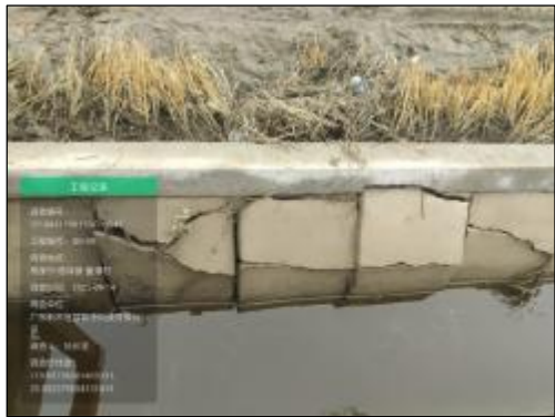
董潭村渠道-09 实施情况：渠道维修，T90渠，长度20m
