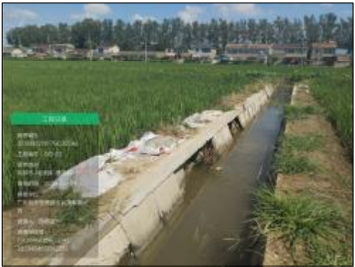
董潭村渠道-02 实施情况：渠道维修，U70渠，长度20m
