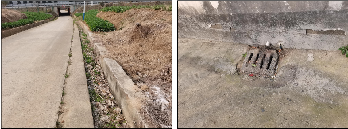
图2-5 路基、路面排水现状图
