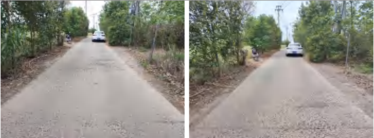
行车道破碎板起点（左）、终点（右）
