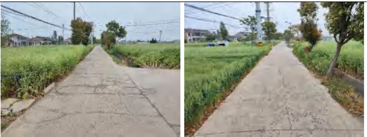
行车道破碎板起点（左）、终点（右）
