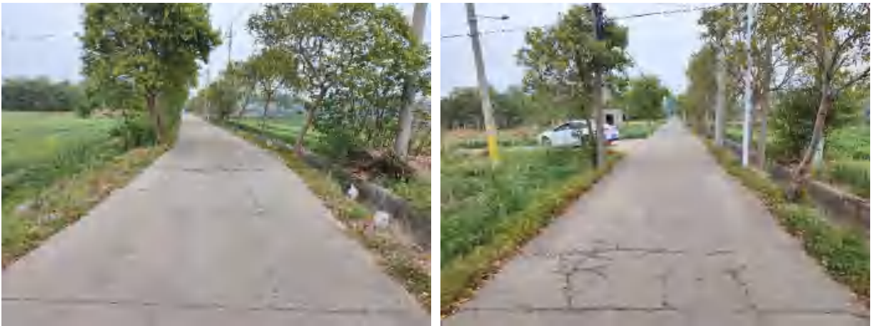
行车道破碎板起点（左）、终点（右）
