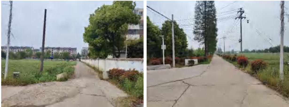
行车道破碎板起点（左）、终点（右）
