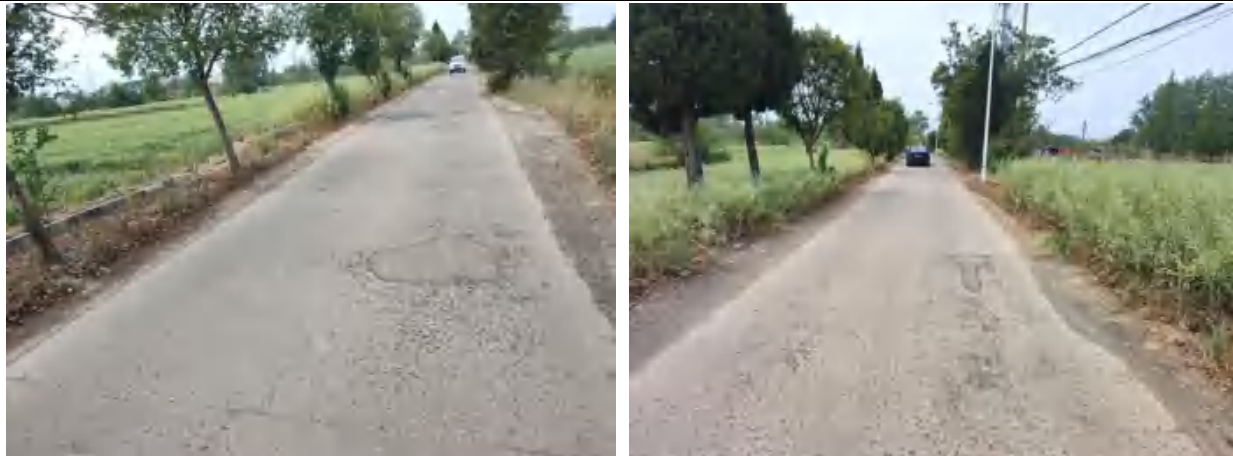
行车道破碎板起点（左）、终点（右）
