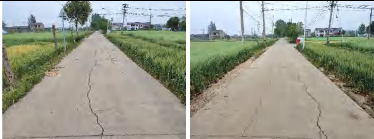
行车道破碎板起点（左）、终点（右）
