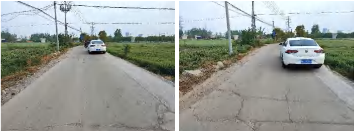
行车道破碎板起点（左）、终点（右）
