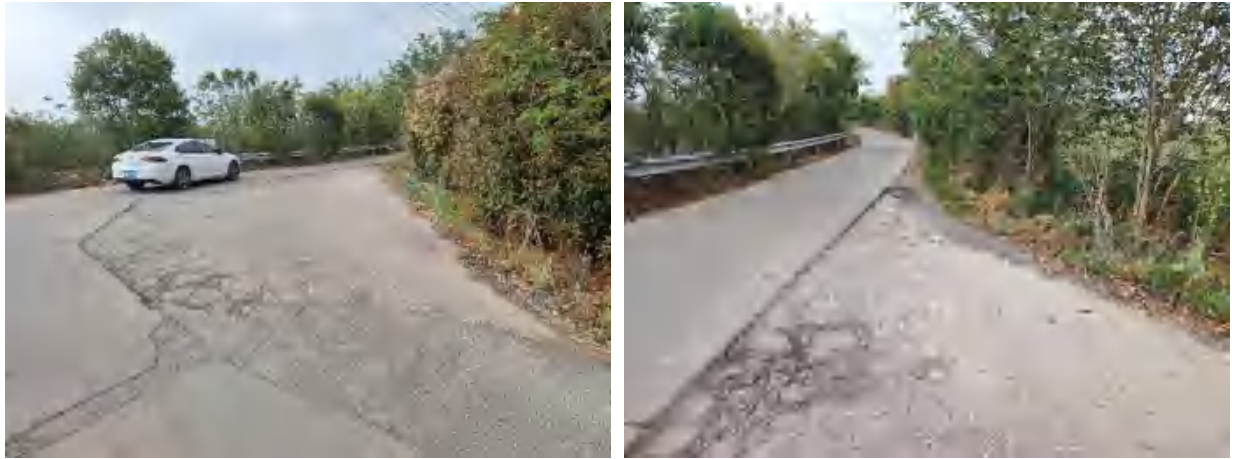
行车道破碎板起点（左）、终点（右）
