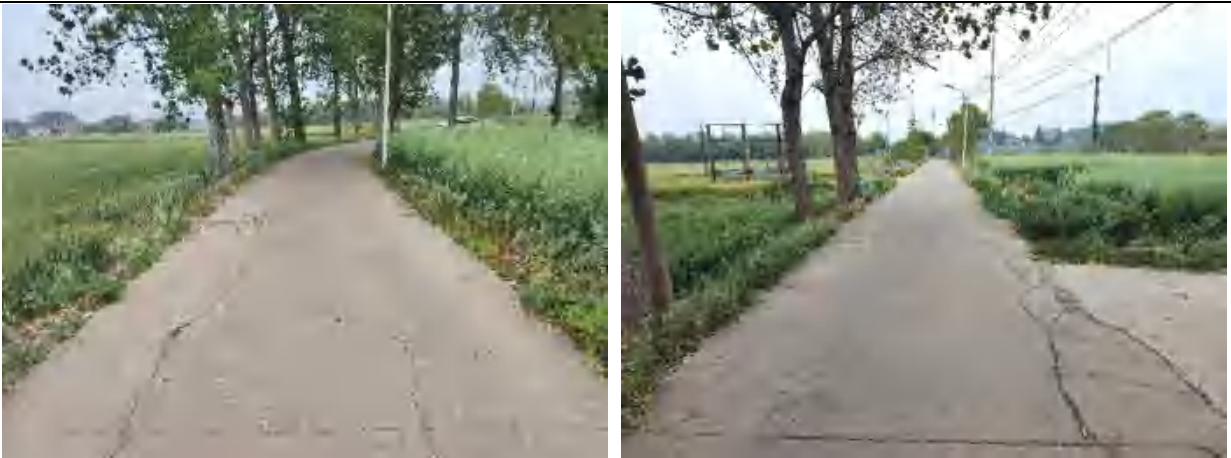
行车道破碎板起点（左）、终点（右）
