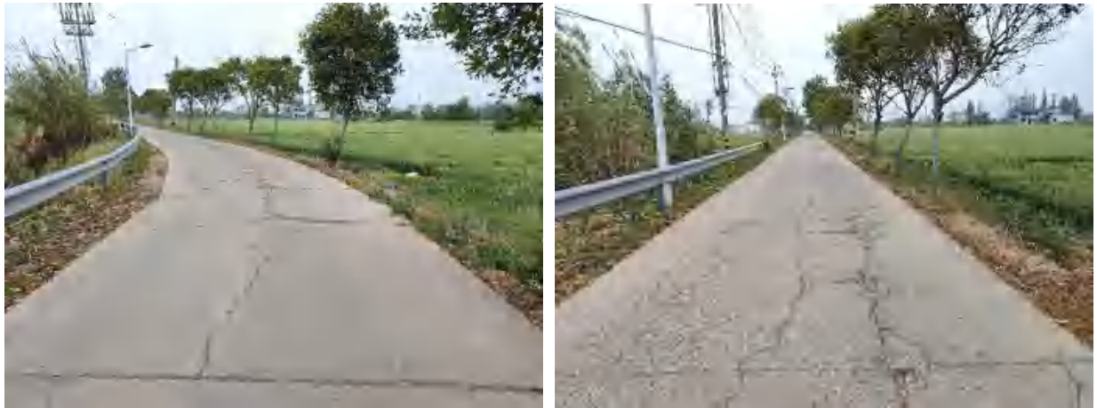
行车道破碎板起点（左）、终点（右）
