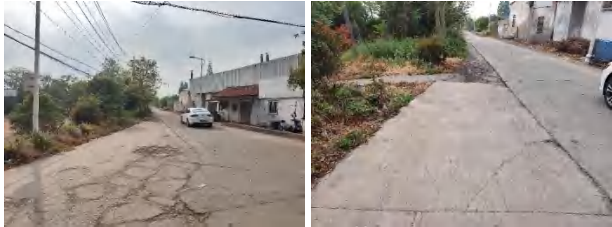
行车道破碎板起点（左）、终点（右）
