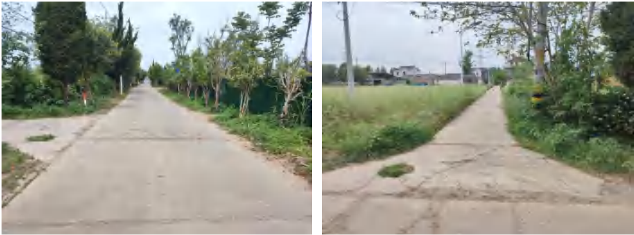
行车道破碎板起点（左）、终点（右）
