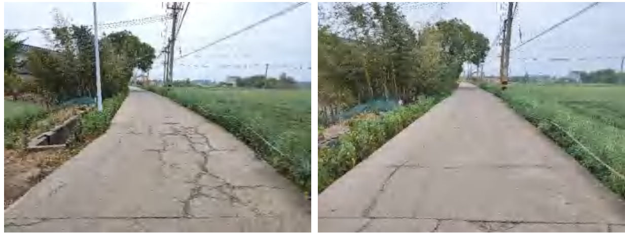
行车道破碎板起点（左）、终点（右）
