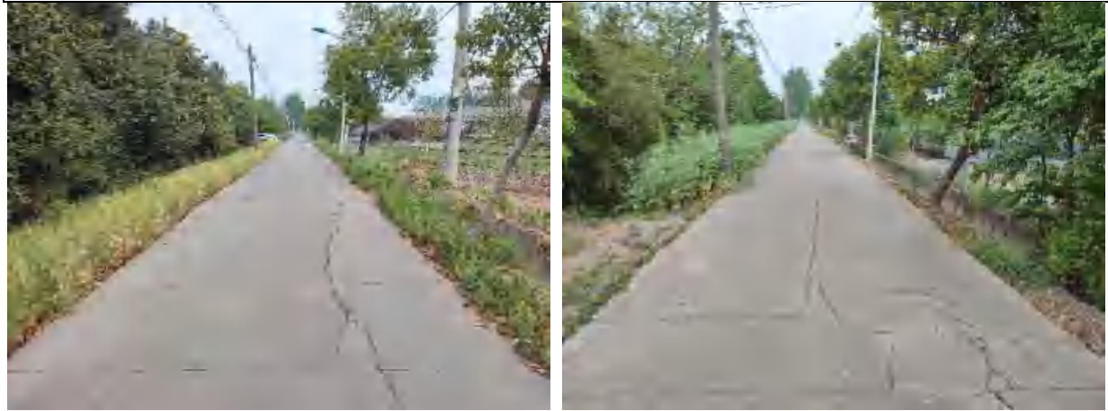
行车道破碎板起点（左）、终点（右）
