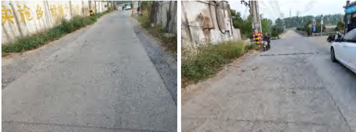
行车道破碎板起点（左）、终点（右）
