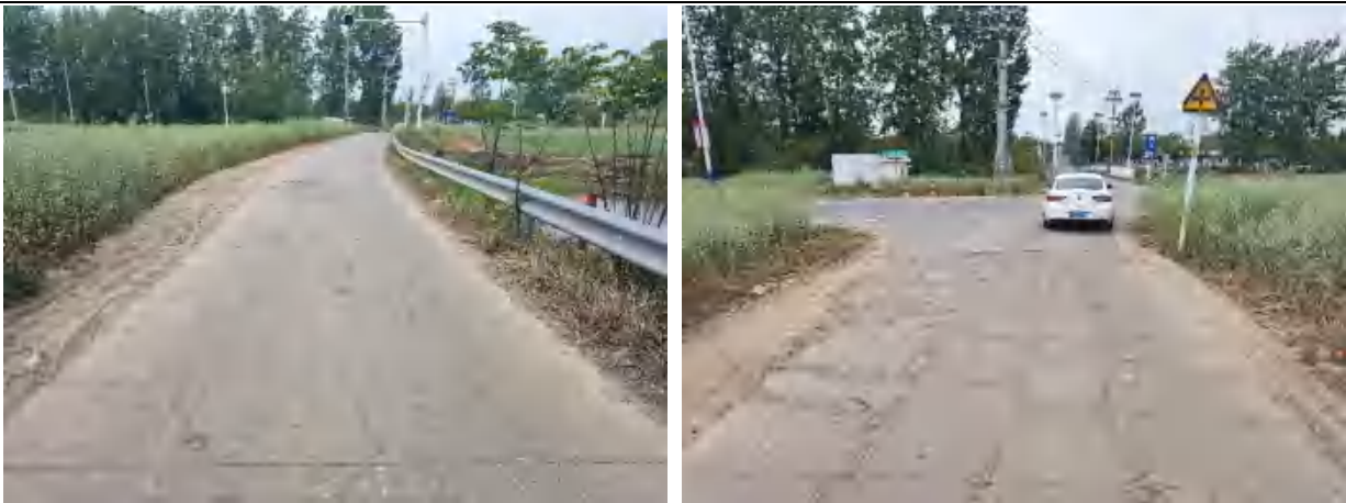
行车道破碎板起点（左）、终点（右）
