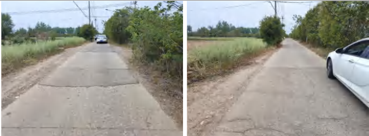
行车道破碎板起点（左）、终点（右）
