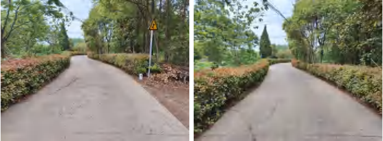
行车道破碎板起点（左）、终点（右）
