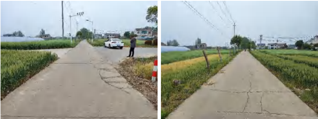
行车道破碎板起点（左）、终点（右）
