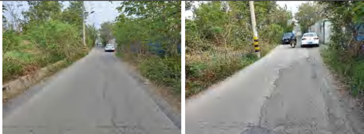
行车道破碎板起点（左）、终点（右）
