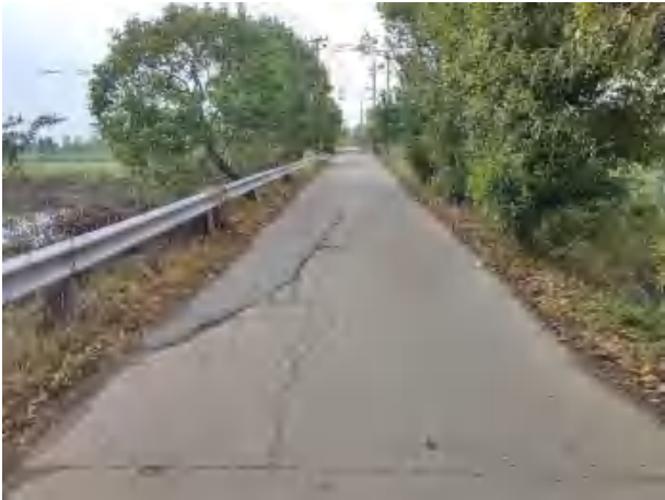
行车道破碎板起点（左）、终点（右）
