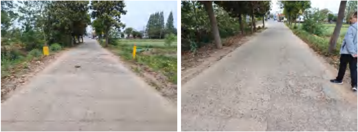
行车道破碎板起点（左）、终点（右）
