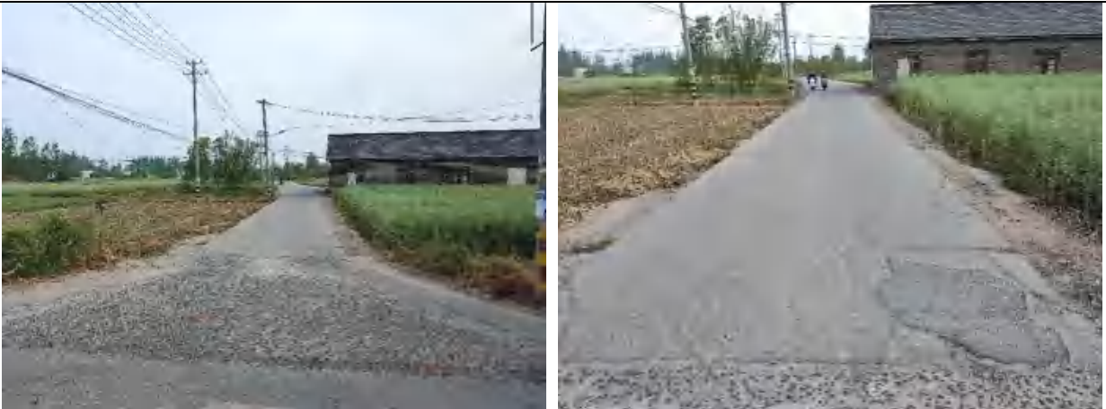
行车道破碎板起点（左）、终点（右）
