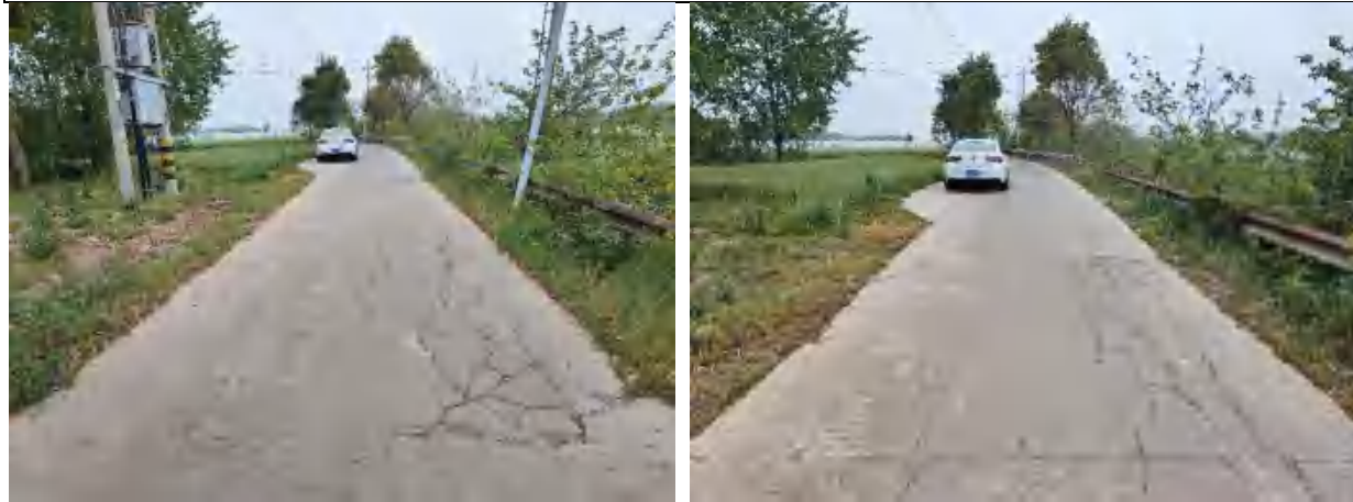
行车道破碎板起点（左）、终点（右）
