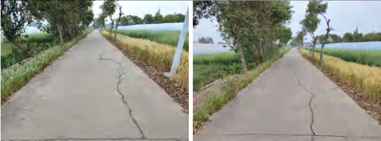
行车道破碎板起点（左）、终点（右）
