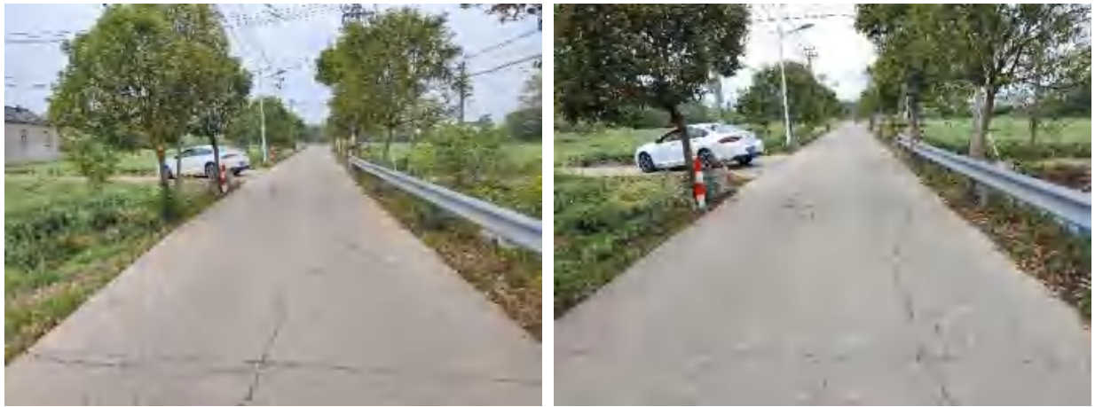
行车道破碎板起点（左）、终点（右）
