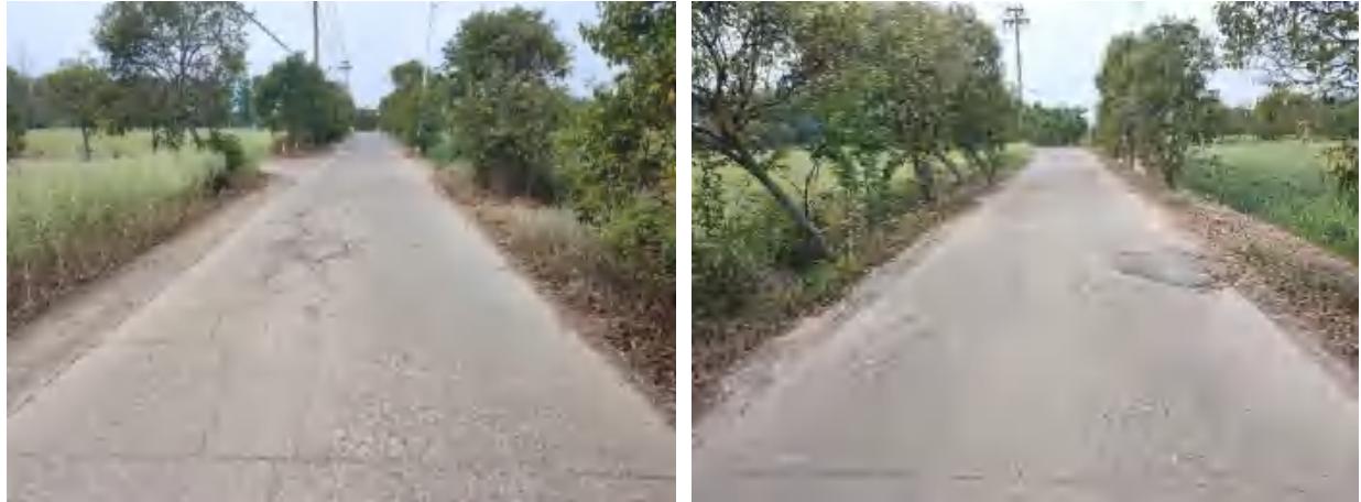
行车道破碎板起点（左）、终点（右）
