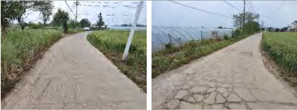
行车道破碎板起点（左）、终点（右）
