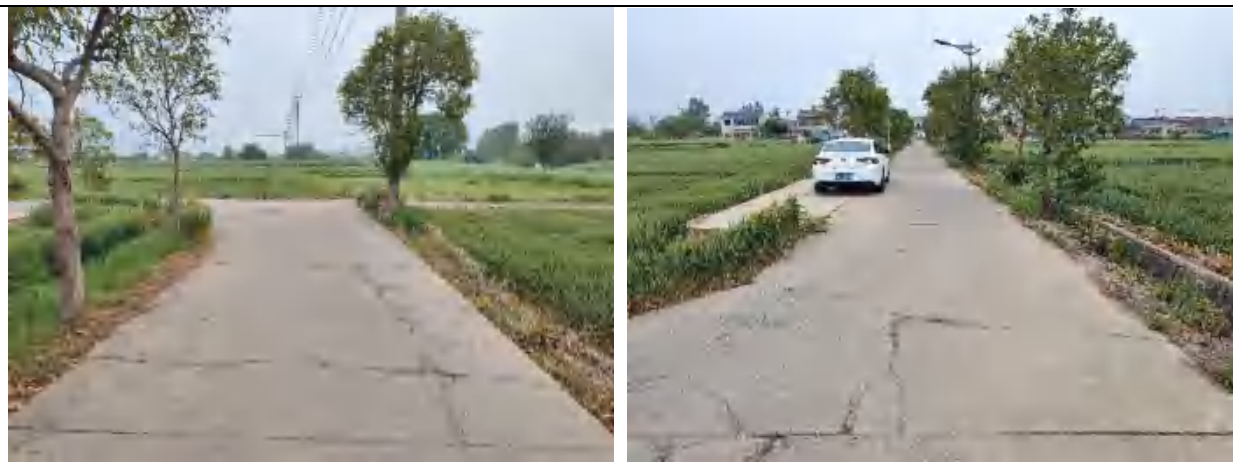
行车道破碎板起点（左）、终点（右）
