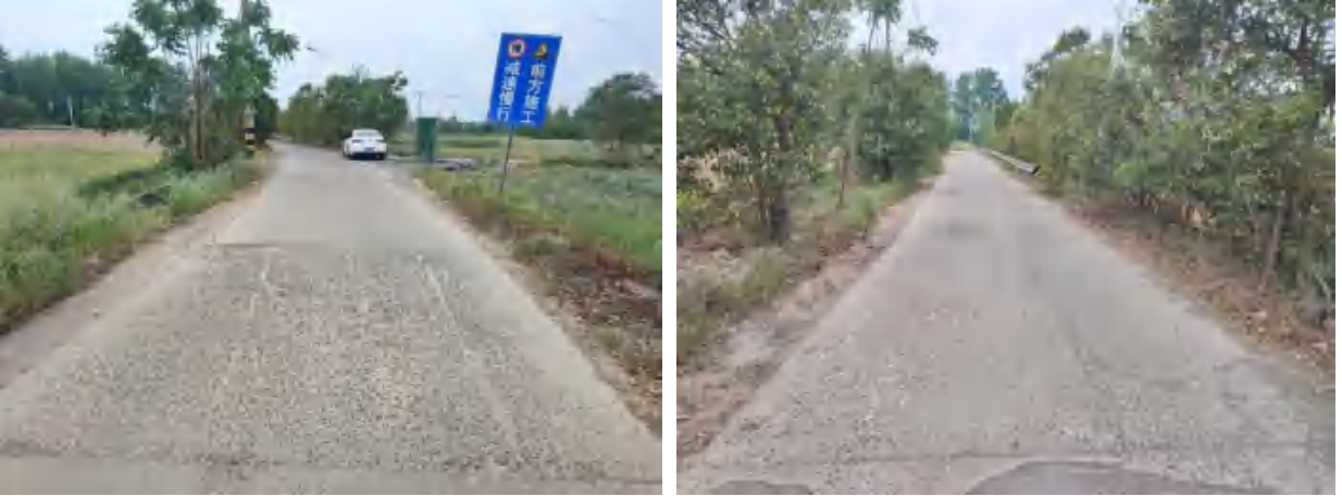
行车道破碎板起点（左）、终点（右）
