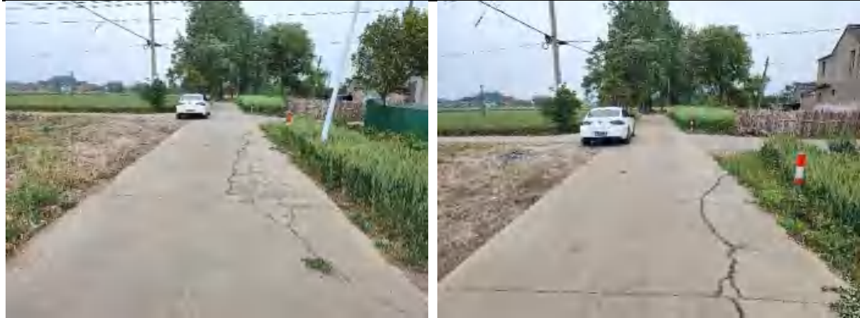
行车道破碎板起点（左）、终点（右）
