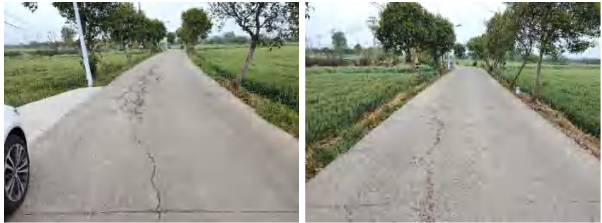
行车道破碎板起点（左）、终点（右）
