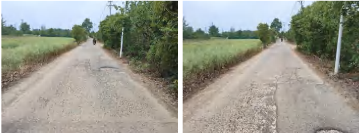
行车道破碎板起点（左）、终点（右）
