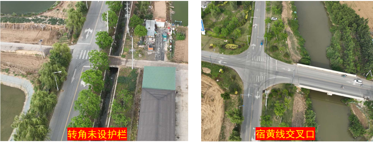
一斗渠路现状照片
